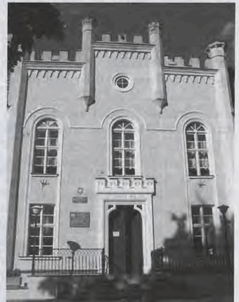
Wejście do budynku
