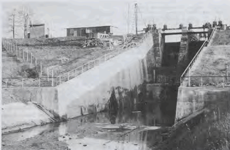
Uszczelnienie betonowych elementów przepustu wody w Elektrowni Gródek
