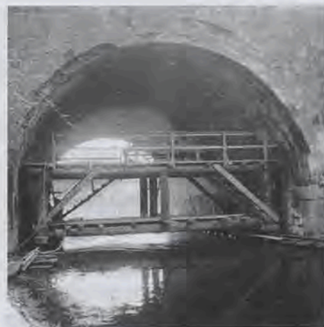
Prace przy przepięciu kolejowym w Dobiegniewie
