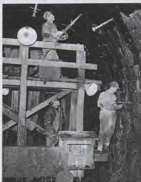
Cementacja tunelu kolejowego w Świerkach
