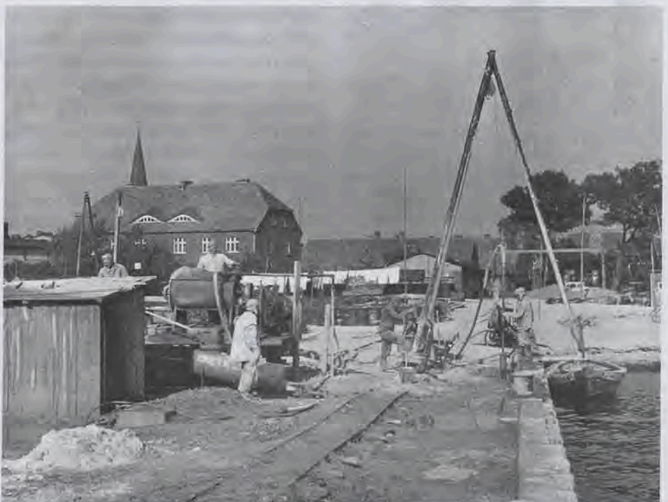
Widok stanowiska robót cementacyjnych w porcie rybackim w Kuźnicy
