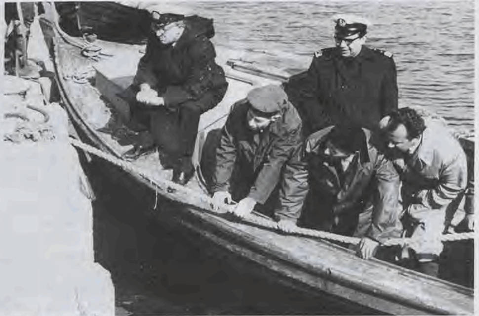
Kontrola szczelności nabrzeża, Kuźnica
