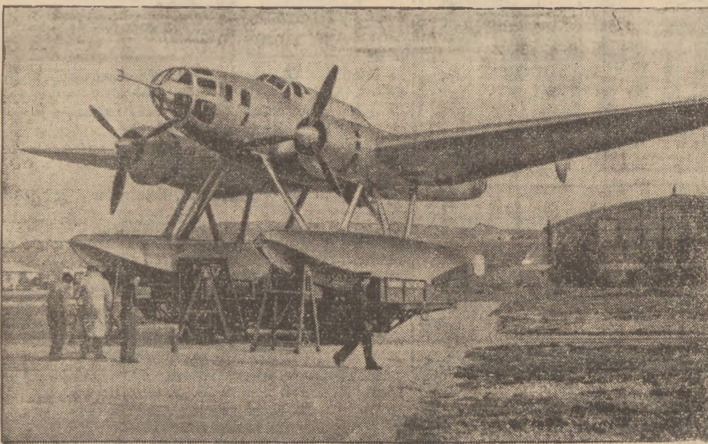
Nowe francuskie samoloty myśliwskie marynarki wojennej wyposażone są w 2 silniki, każdy o sile 900 KM.
