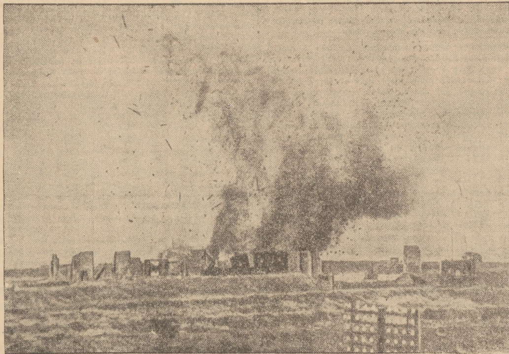
W Anglii przeprowadzono szereg prób ze schronami przeciwlotniczymi i w tym celu spowodowano nad podziemnym schronem wybuch 450-funtowej bomby. Po wybuchu okazało się, że schron był nietknięty.
