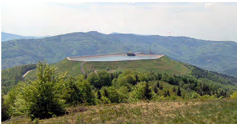
Fot: Elektrownia Szczytowo-pompowa Porąbka-Żar
