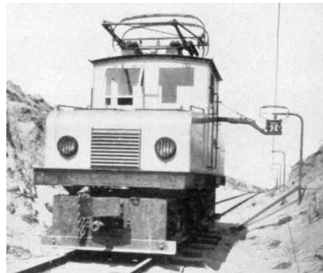
Fot. 5.29. Lokomotywa przemysłowa z bocznym odbierakiem pałkowym [24]
