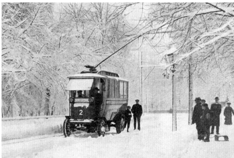
Fot. 5.7. Trolejbus z odbierakiem drążkowym łyżkowym podwójnym [4]
