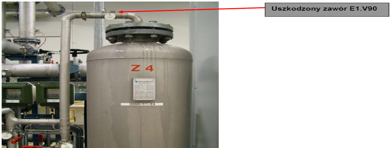
Rys.4.5. Awaria zaworu odpowietrzającego wg [źródła własne]
