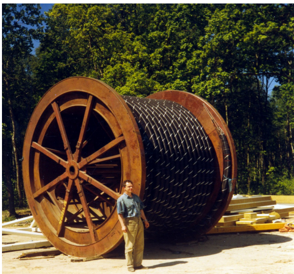
Rys.3.6. Odcinek 500 m kabla głównego przygotowany do rozwijania na łądzie po polskiej stronie wg [źródła własne]
