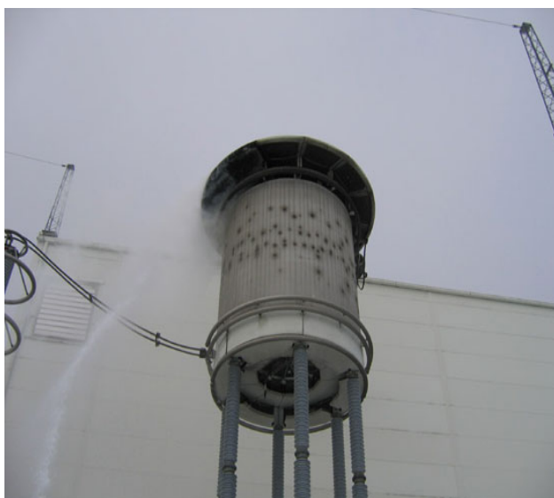
Rys.4.2. Naprawa dławika wygładzającego po polskiej stronie łącza wg [źródła własne]
