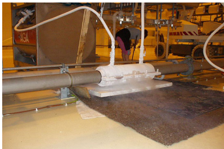
Rys.4.6. Przygotowanie do wymiana przepływowościomierza po stronie polskiej wg [źródła własne]
