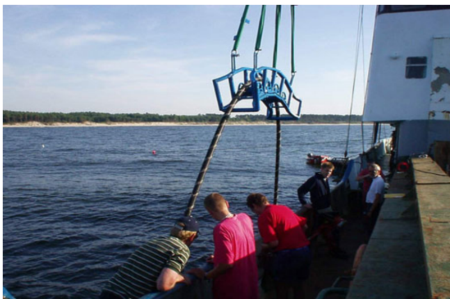
Rys.4.1. Naprawa uszkodzonego kabla powrotnego wg [źródła własne]
