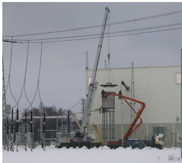
Rys.4.2. Naprawa dławika wygładzającego po polskiej stronie łącza wg [źródła własne]
