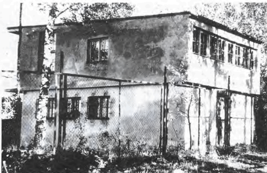
Budynek socjalno-mieszkalny w Bazie
