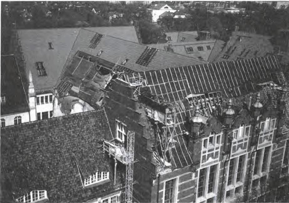
Fot. 4. Modernizacja dachu nad Aulą (stan 23.04 2002 r.)
