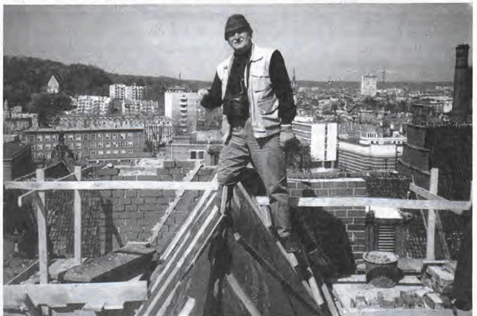
Fot. 5. Rozbiórka wychylonej górnej części atyki dachu nad Aulą, widoczna też na fot. 4 (stan 22.04.2002 r.)
