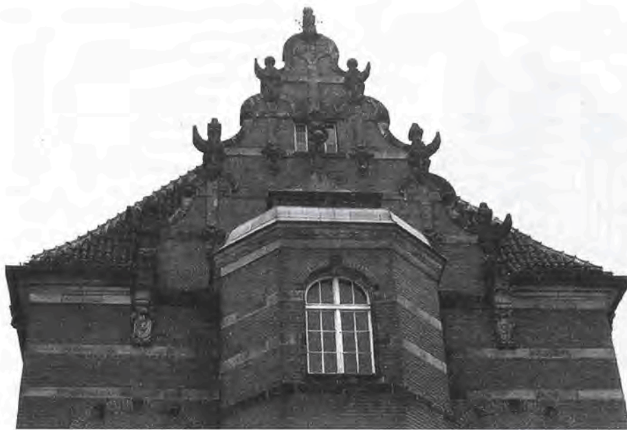
Fot. 4. Północno-wschodni szczyt i zwieńczenie klatki schodowej. Fot. J. Ciemnołoński
