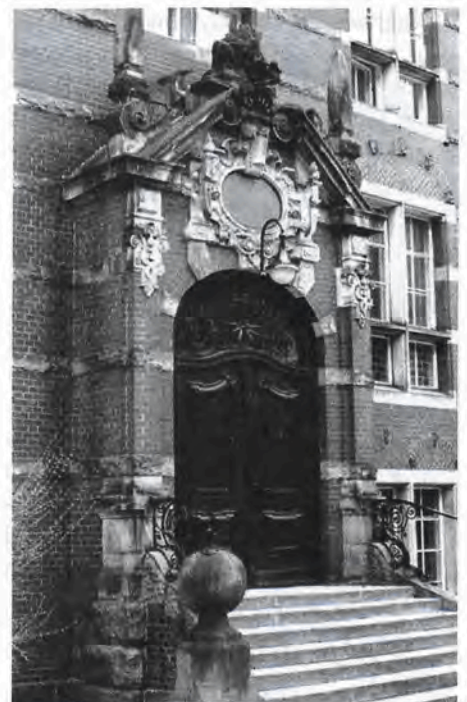
Fot. 9. Portal główny budynku. Fot. J. Ciemnołowski
