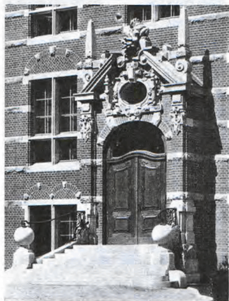
Fot. 2. Portal główny d. Instytutu Elektrotechniki, stan – 1904 r. (publ. 1. Tabl. XXII)
