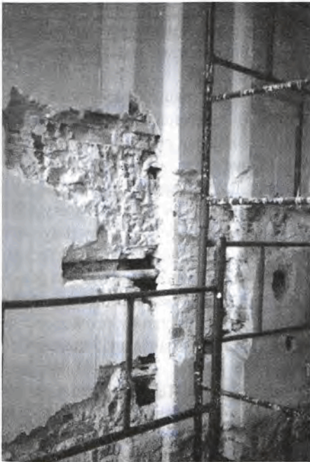
Fot. 6. Ściana przydzielna Auli – widoczna skuta warstwa ściany dla uzyskania efektu pilastra i wielkogabarytowy kanał za nią
