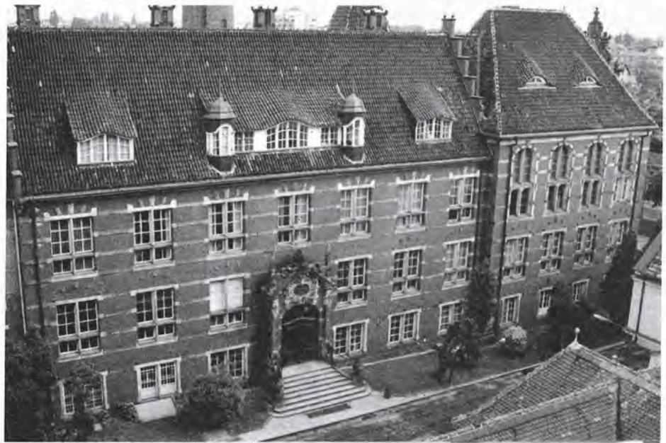
Budynek Wydziału Elektrotechniki i Automatyki (fot. B. Urbanowicz)
