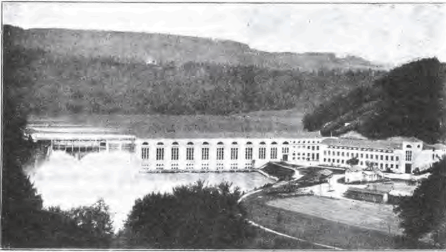
Fot. 3. Zakład wodny Mühleberg. Widok ogólny
