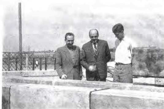
Nowe odcinkowe prefabrykowane pale sprężone kablami. Pierwsze egzemplarze prototypu na placu budowy w Gdyni na Skwerze Kościuszki w Basenie Prezydenta, rok 1957. Od lewej: mgr inż. Eugeniusz Dembicki – st. asystent, prof. dr inż. Stanisław Hueckel – kierownik Katedry Fundamentowania, mgr inż. Andrzej Wójcik – asystent naukowo-techniczny
