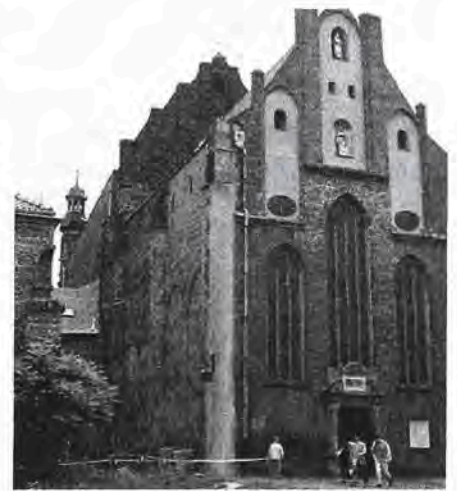
Luteranie w Gdańsku wielokrotnie atakowali klasztory, szczególnie karmelitów, co doprowadziło m. in. do zniszczenia nawy kościoła św. Józefa. Siegała ona do ulicy, a jej ślady widać na bocznej ścianie do dziś
