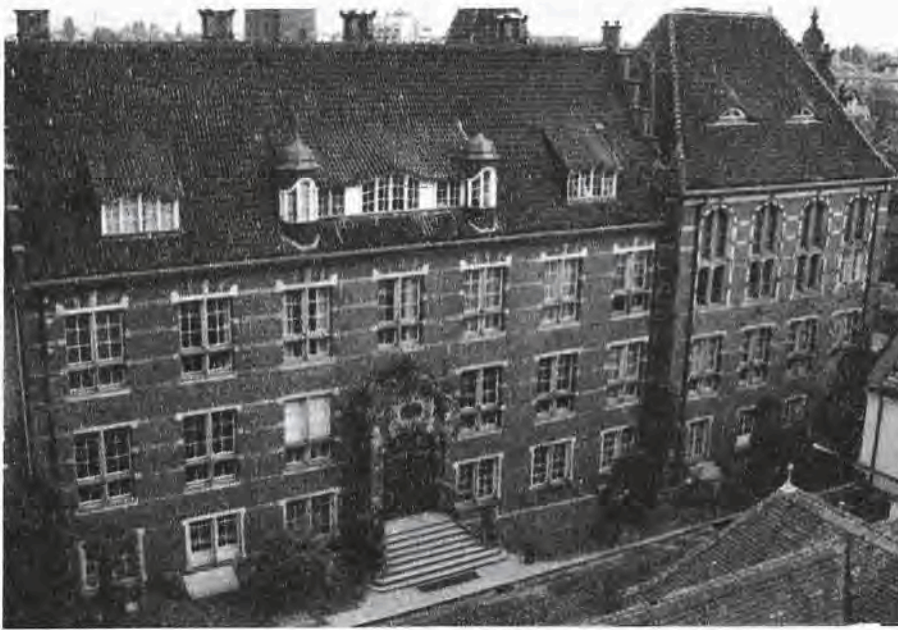
Budynek Wydziału Elektrotechniki i Automatyki (fot. B. Urbanowicz)
