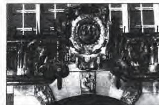
Detal architektoniczny Gmachu Głównego (fot. T. Chmielowiec)
