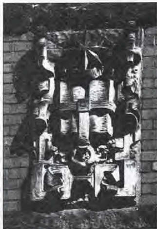
Detal architektoniczny Gmachu Głównego (fot. T. Chmielowiec)
