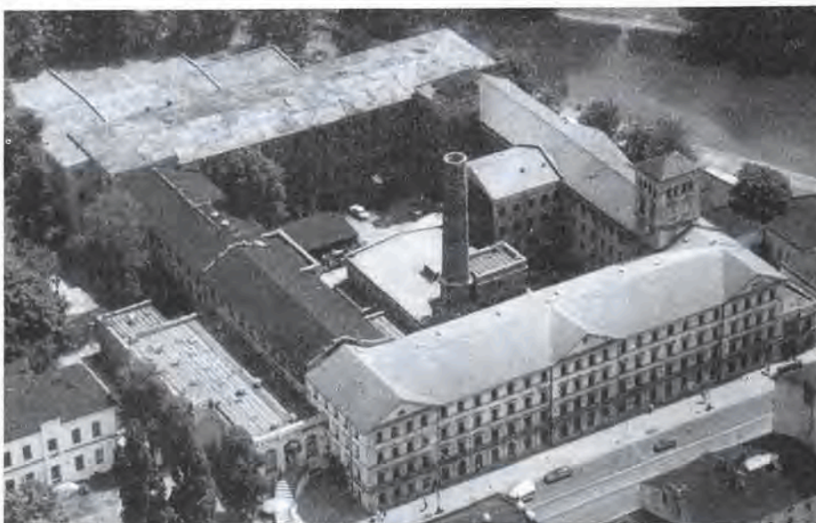
Łódź, Centralne Muzeum Włókiennictwa; komin byłej kotłowni jest jednym z kilku zachowanych z ponad 300 niegdyś dominujących nad miastem (fot. W. Stępień)
