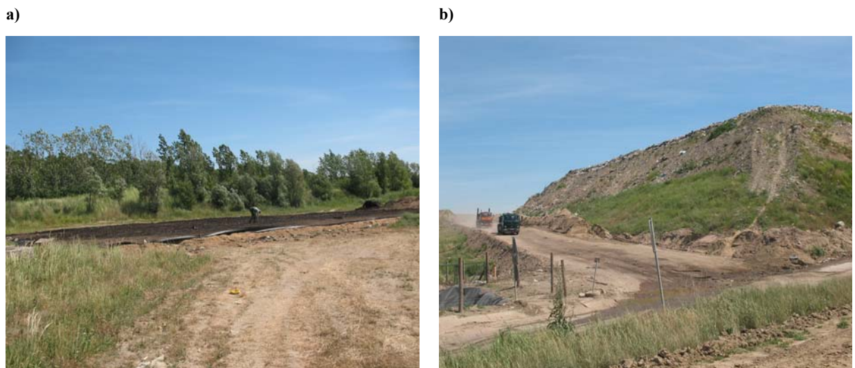
Rysunek 9. Widok kompostowni (a) i czynnej kwatery składowej (b).
