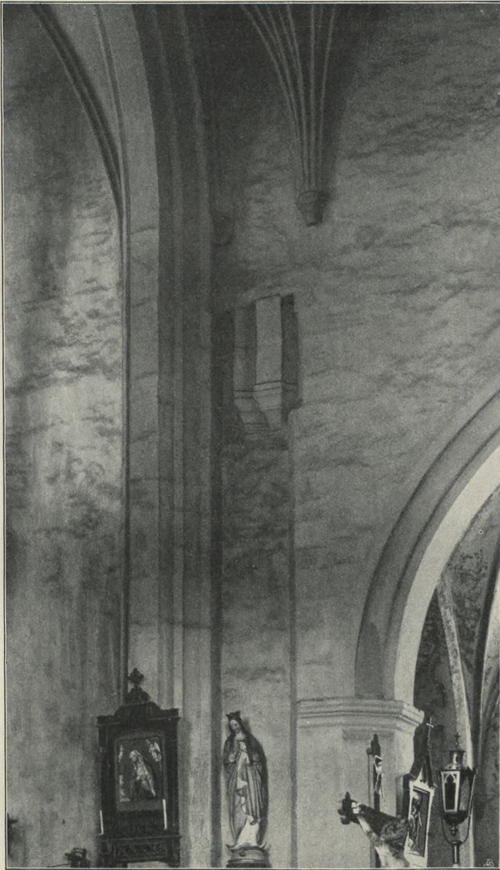
Fig. 42. Chammünster. Südlicher Pfeiler des spätgotischen Chorbogens mit dem Anschluß des spätgotischen Langhauses an den frühgotischen Chor.
