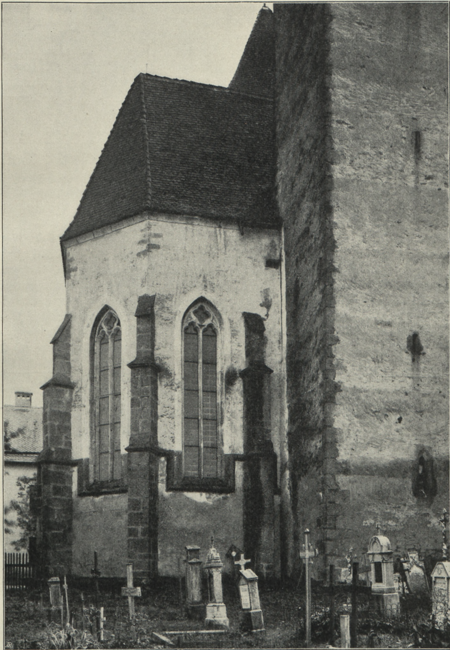
Fig. 47. Chammünster. Ansicht des Chorbaues von Norden.
