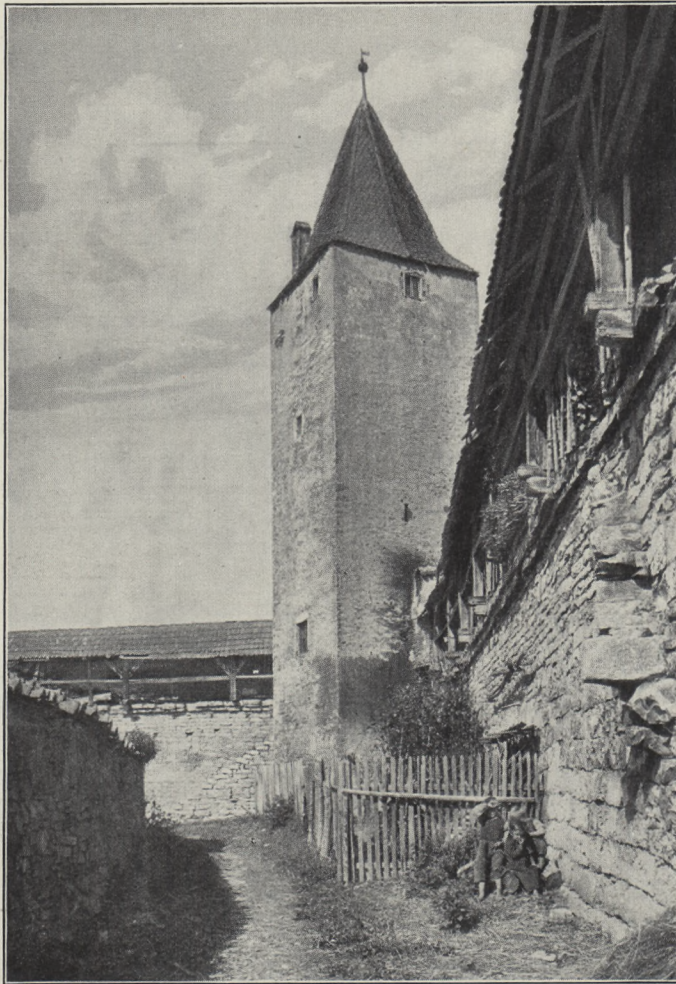
Fig. 39. Berching. Stadtmauer an der Nordwestecke, mit dem Frauenturm.
