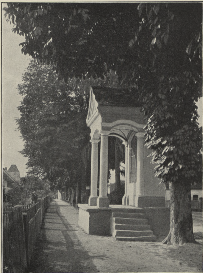
Fig. 9. Beilngries. Wegkapelle vor der Stadtmauer im Osten der Stadt.
