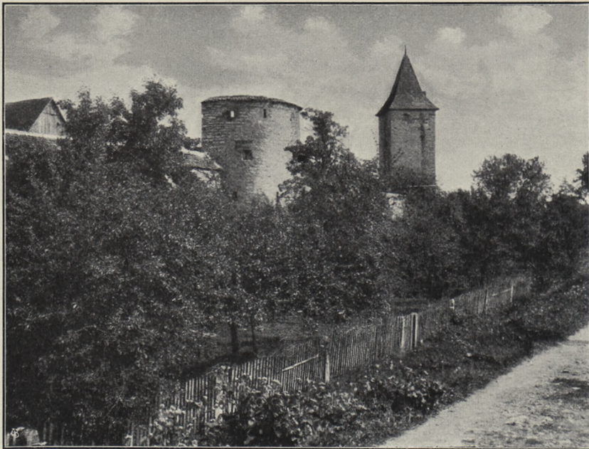
Fig. 37. Berching. Partie an der westlichen Stadtmauer außen, mit Halbturm und Bürgerturm.
