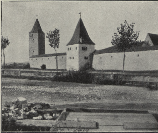
Fig. 42. Berching. Stadtmauerpartie westlich vom Gredinger Tor, mit Neumaier- und Frauenturm.
