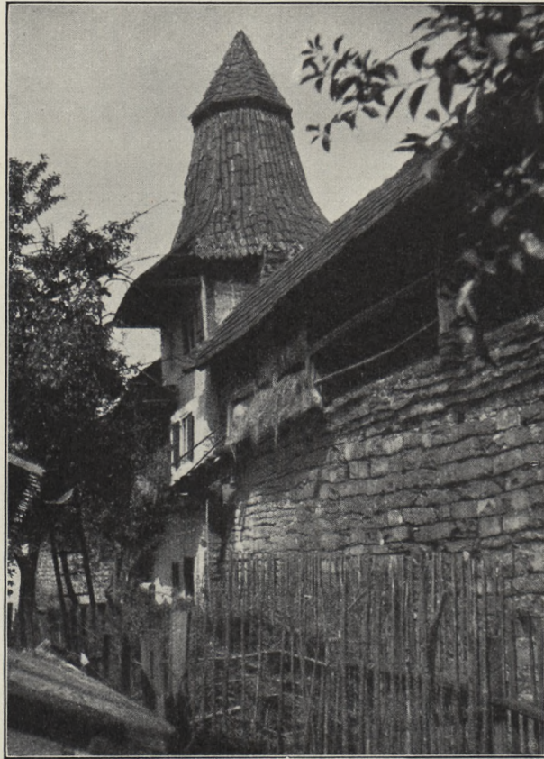
Fig. 41. Berching. Der Storchenturm an der nördlichen Stadtmauer.
