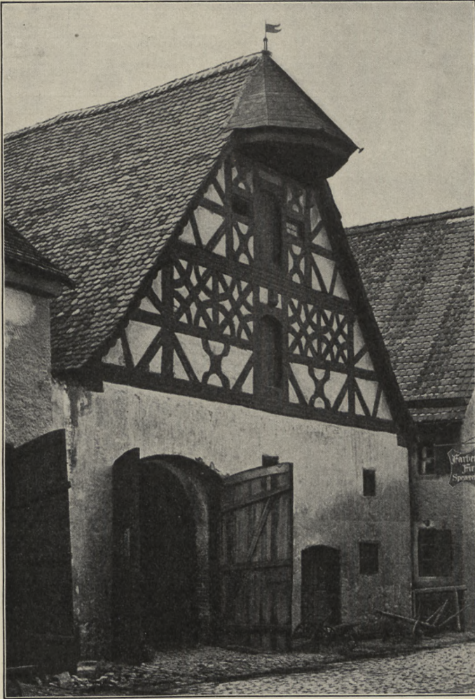
Fig. 58. Berching. Scheune mit Fachwerkgiebel.
