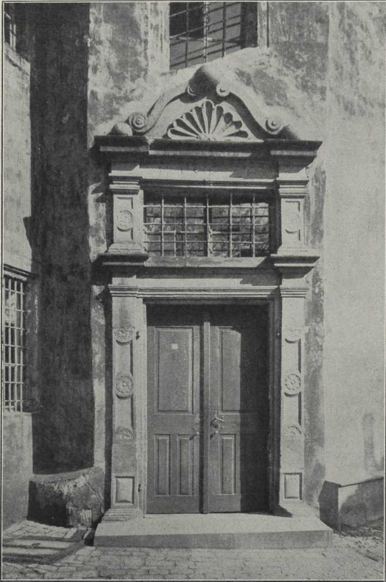
Fig. 90. Sulzbach. Eingangsportal am Treppenturm des Saalbaues.
