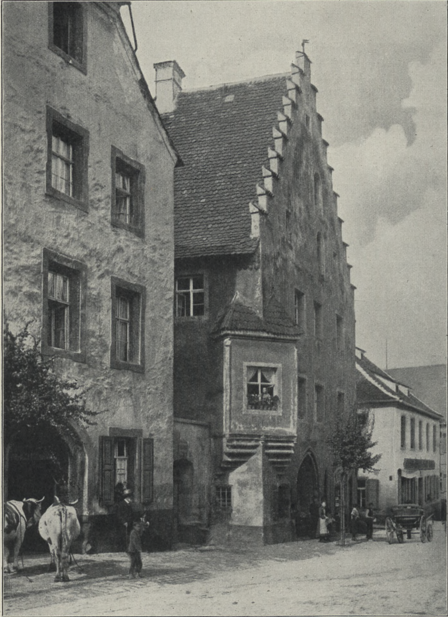
Fig. 93. Sulzbach. Das Weißbeckhaus in der Rosenbergerstraße.
