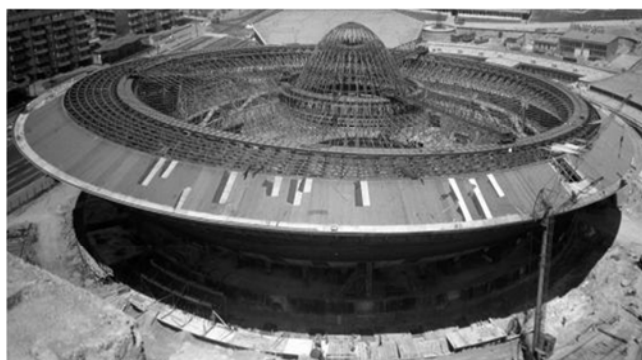
Rys. 37 Budowa hali „Spodek” w Katowicach
