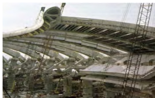
Rys. 4 Stadion w Montrealu podczas budowy
