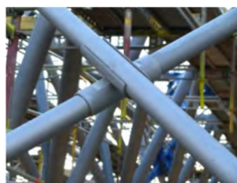
Rys. 52 Przekładka ciągien
