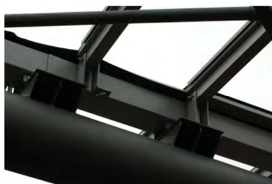
Rys. 129 Podkonstrukcja poszycia
