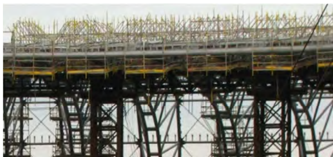
Rys. 76 Pomosty robocze
