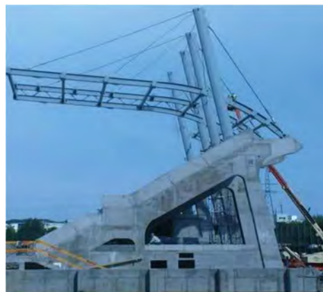
Rys. 19 Stadion Rugby w Gdyni (w trakcie budowy)
