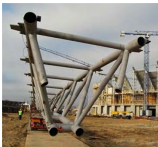
Rys. 106 Krzyżulce w miejscu styku montażowego
