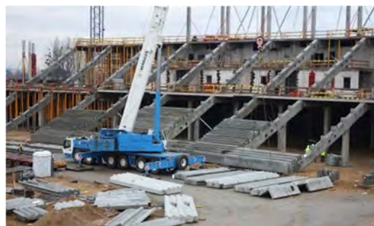
Rys. 46 Montaż elementów prefabrykowanych
