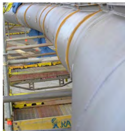
Rys. 104 Imperfekcja ringu
