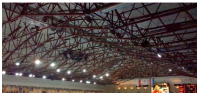
Rys. 36 Zadaszenie lodowiska „Torwar” w Warszawie
