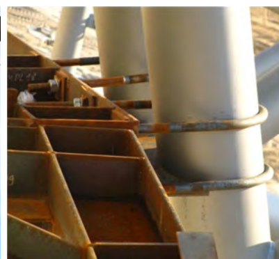
Rys. 67 Mocowanie segmentu elewacyjnego dźwigara w łożysku oraz do korony trybun
