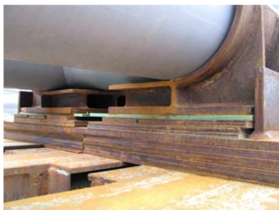
Rys. 70 Łoże montażowe pod dźwigar
