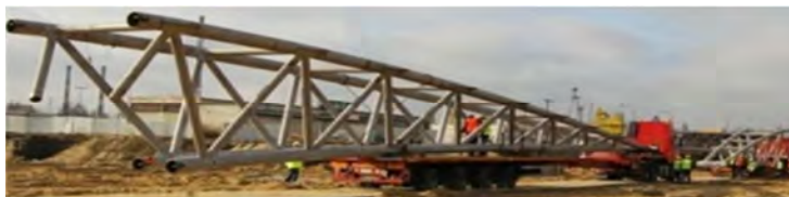
Rys. 65 Montażowy segment dachowy dźwigara
