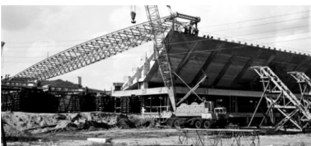
Rys. 38 Budowa hali „Olivia” w Gdańsku
