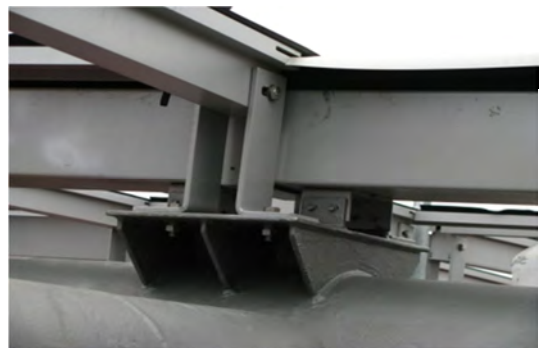
Rys. 54 Stoliki pod płatwie poszycia
