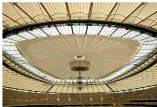
Rys. 35 Stadion Narodowy zamknięty
