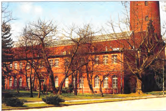
Il. 8. Obecnie: Wydział Mechaniczny, Katedra Techniki Ciepłej, Laboratorium Maszynowe; stan 2000
