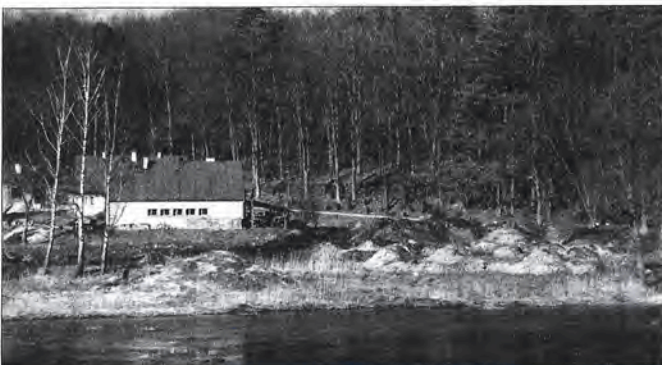
Teren dawnej filii Instytutu Rybactwa Śródlądowego w Olsztynie – kolejny etap dewastacji: zwożenie śmieci, gruzu itp.
