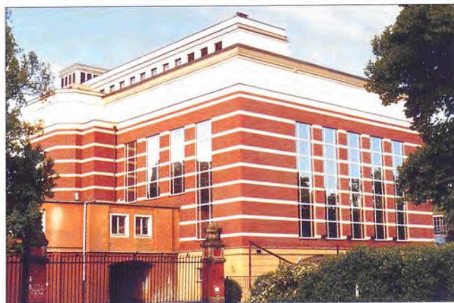
Il. 22. Nowa kotłownia (1954); obecnie: Auditorium Novum
