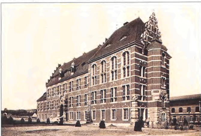
Il. 3. Instytut Elektrotechniczny; stan 1904
