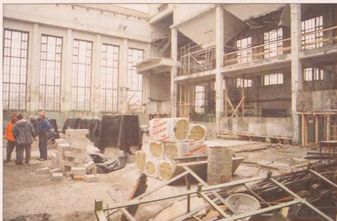
Plac budowy byłej kotłowni 1997-98
