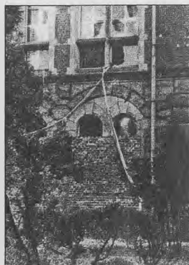
Na pierwszym piętrze okno sali A 154 (*)
