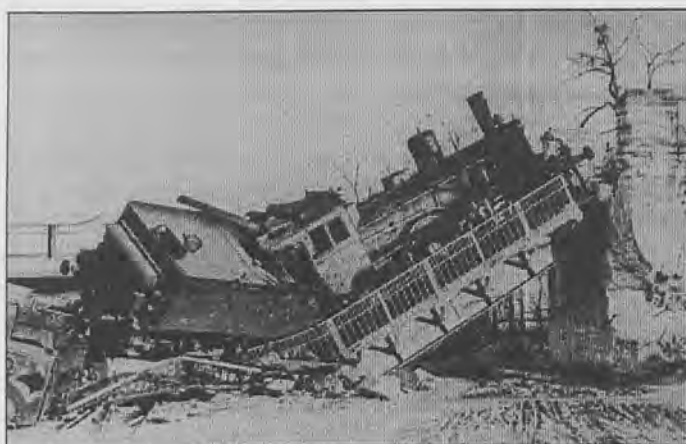
Wysadzony wiadukt koło "Zajezdni Wrzeszcz"; widok od strony Oliwy (lato 1945 r.)
