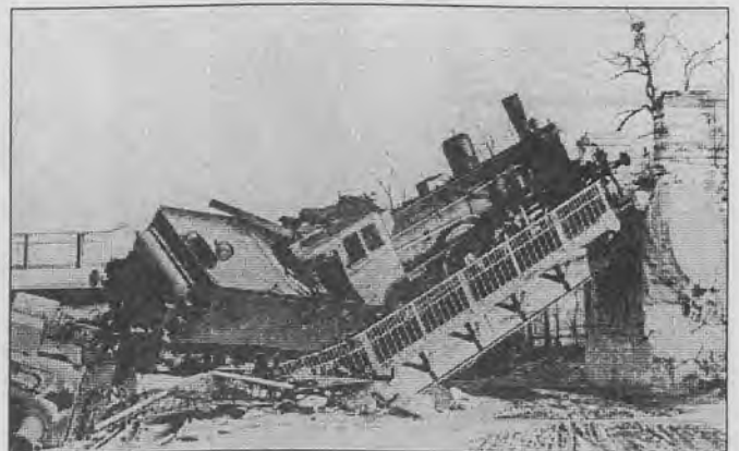
Wysadzony wiadukt (widok od strony Oliwy), 1945 r.
