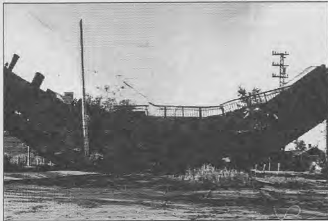
Wysadzony wiadukt (widok od strony Wrzeszcza), 1945 r.
