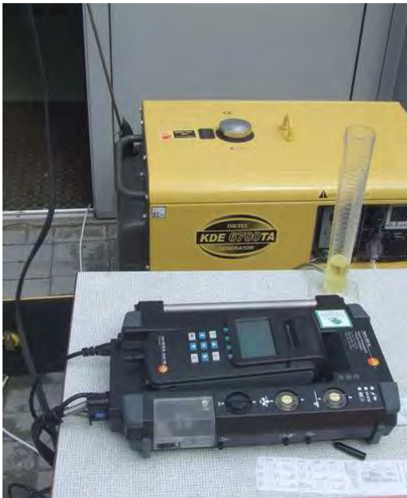
Rys. 8.1. Analizator Testo 350 XL z umiejscowioną w rurze wydechowej generatora sondą pomiarową.
