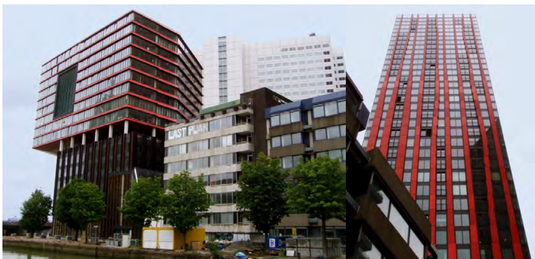
Ryc. 60. Nowe realizacje mieszkaniowe w centrum Rotterdamu. Widoczny budynek przygotowany do rozbiórki. Fot. własne.
