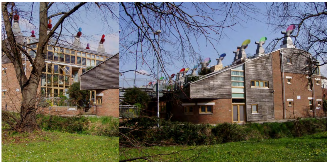
Ryc. 68. BedZED - widok na typowy ciąg zabudowy. Fot. własne.
