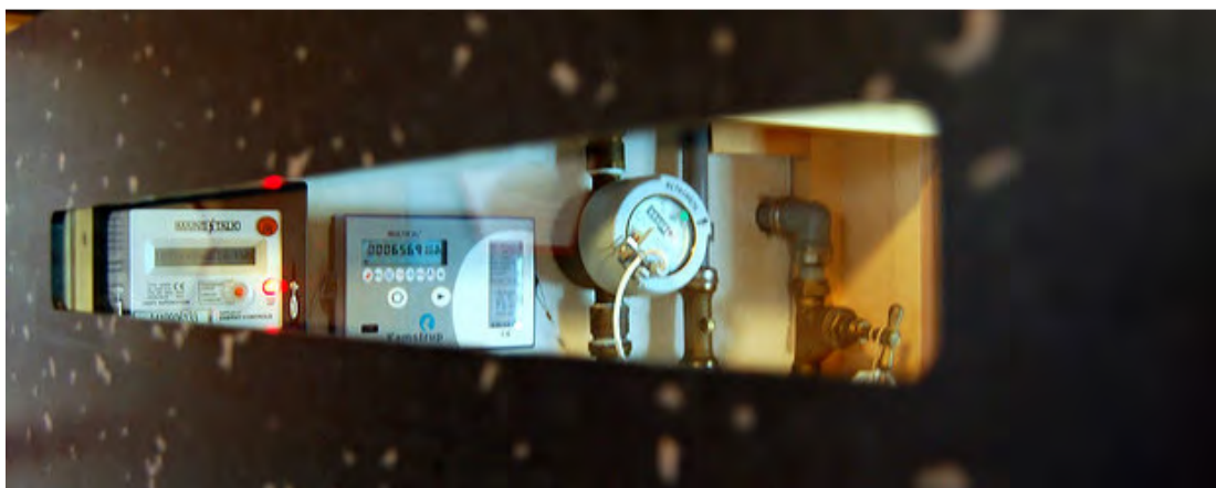
Ryc. 73. Wyeksponowane w kuchni liczniki umożliwiające stałe monitorowanie zużycia energii i wody. Źródło: BioRegional.
