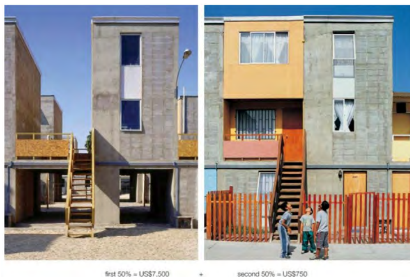
Ryc. 63. A. Aravena: Quinta Monroy Housing w Iquique, Chile (2003–05). Po lewej widok po oddaniu do użytkowania, po prawej rozbudowa wykonana przez mieszkańców. Źródło: strona internetowa projektanta.
