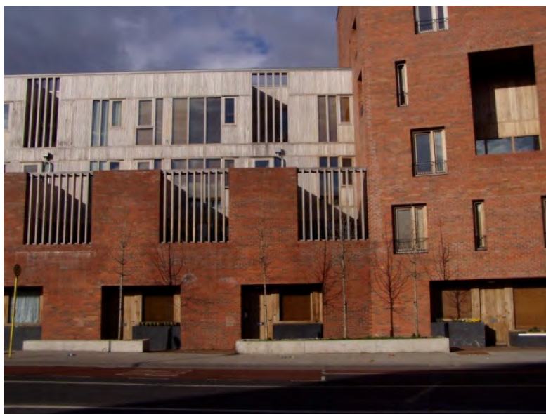
Ryc. 29. Timberyard – nagradzany w konkursach architektonicznych budynek wielorodzinny z mieszkaniami socjalnymi w Dublinie proj. O'Donnell+Tuomey. Fot.własna.
