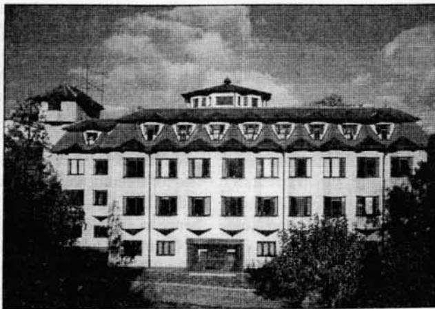
Budynek Instytutu Oceanologii PAN zbudowany w 1993 r. w Sopocie przy ul. Powstańców Warszawy 55 The Institute Building built in 1993 in Sopot, at 55 Powstańców Warszawy Street
