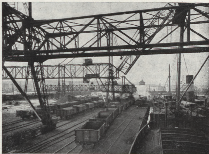
BRÜCKENKRÄNE AUF DER KOHLENMOLE.
