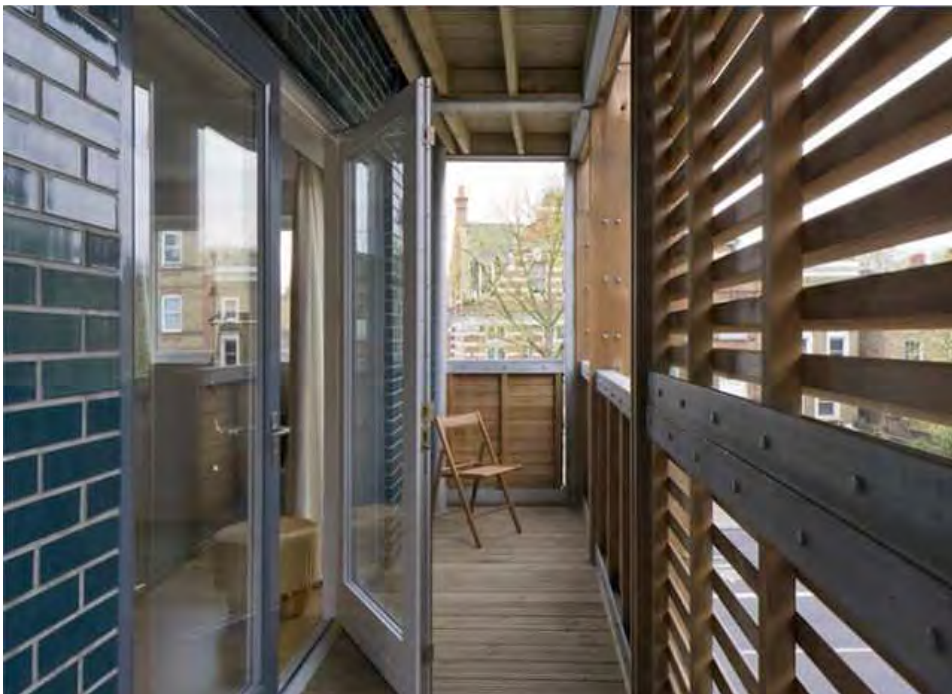
il. 33. Sarah Wigglesworth Architects, Wardroper house, detal elewacji. il. 34. Sarah Wigglesworth Architects, Wardroper house, balkon. Źródło fotografii, strona internetowa pracowni: http://www.swarch.co.uk/projects/wardroper-house/info/
