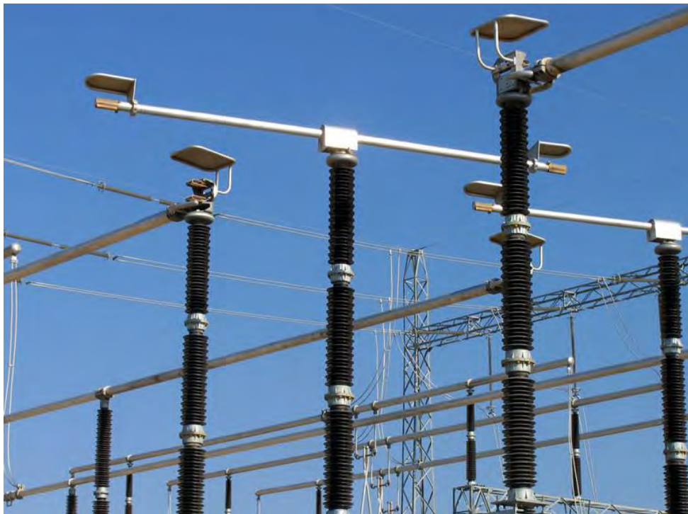
Fot. 2.4. Odłącznik poziomoobrotowy trójkolumnowy (dwuprzewowy) ( http://www.hapam.pl ).
