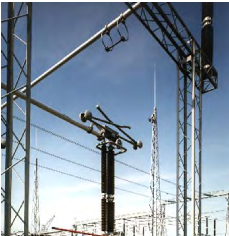
Fot. 2.5. Odłącznik pionowy pantografowy ( http://www.hapam.pl ).
