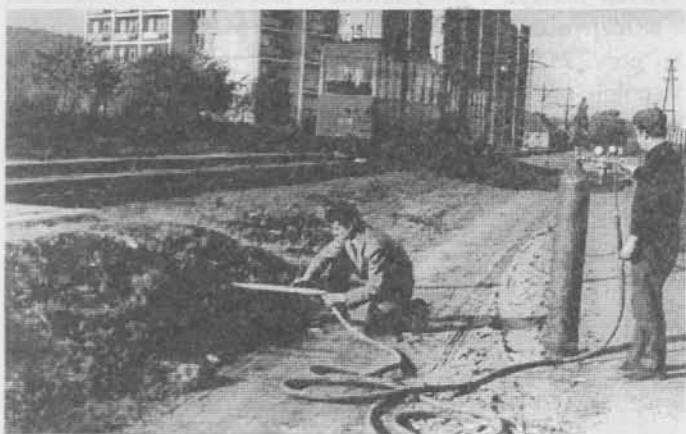
Drażenie otworu pod linią tramwajową za pomocą pneumatycznego przebijaka gruntu pod nazwą "KRET"
