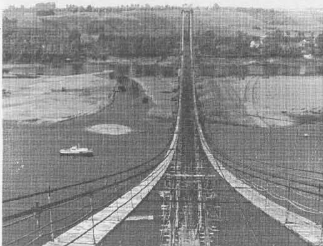
Kładka montażowa mostu wiszącego w Płocku
