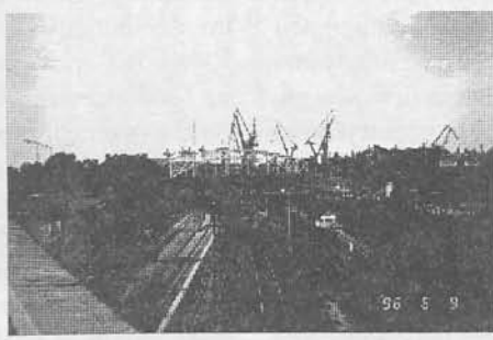
Rys. 9. Wiadukt kratowy przy Bramie Oliwskiej w Gdańsku
