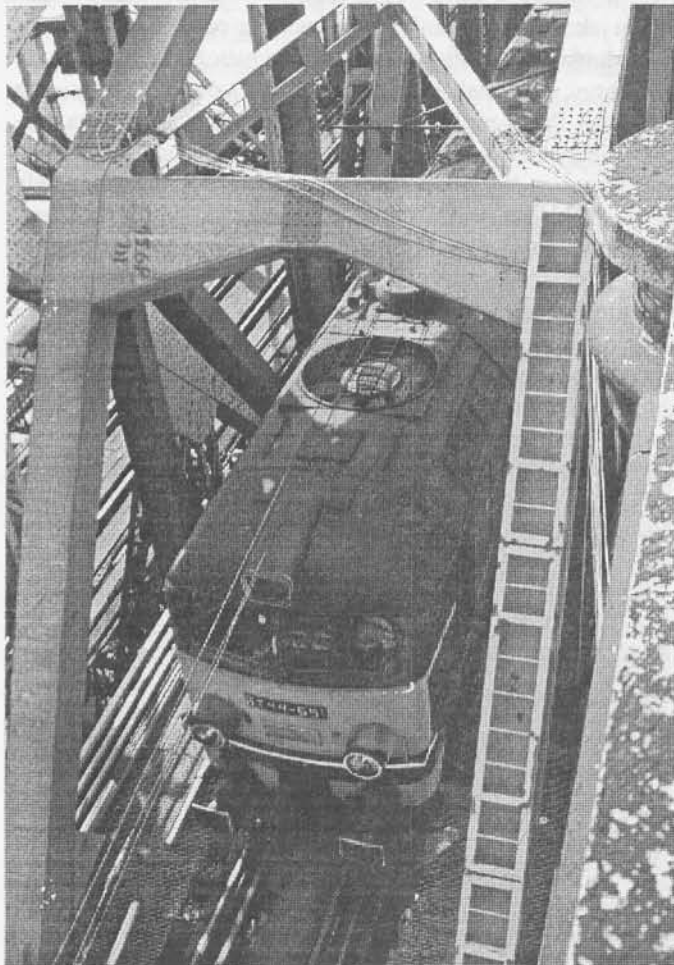
Statyczne ustawienie obciążenia próbnego - 2 lokomotywy St44 oraz 5 węglarek
