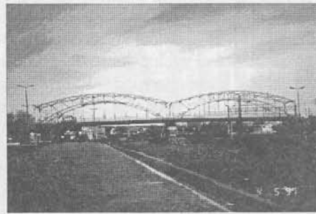
Rys. 10. Wiadukt kratowy w ciągu ul. Kościuszki w Gdańsku
