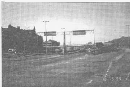
Rys. 5. Wjazd na estakadę przy ul. Okopowej w Gdańsku
