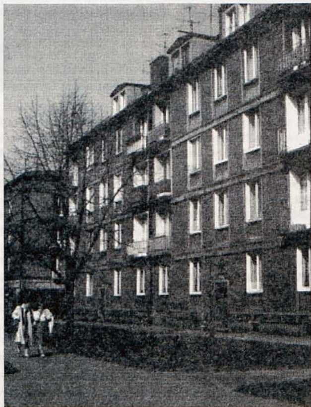
Gdańsk, Śródmieście Północ, domy mieszkalne I stopnia uprzemysłowienia. Arch. S. Sowiński
