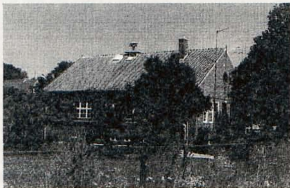
Fot. 8. Pseudowiejska przepompownia wody - Sobieski
