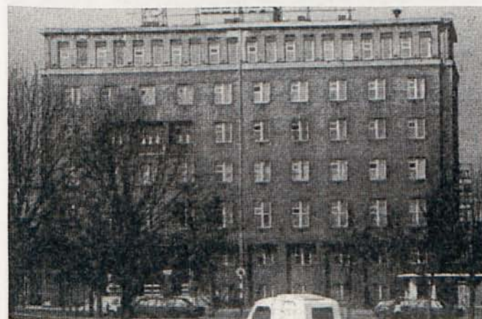
Gdańsk, Budynek Zarządu Portów Gdańsk-Gdynia. Architekci: W. Minkiewicz, W. Rembiszewski; współpraca: A. Matoń, L. Taraszkiewicz
