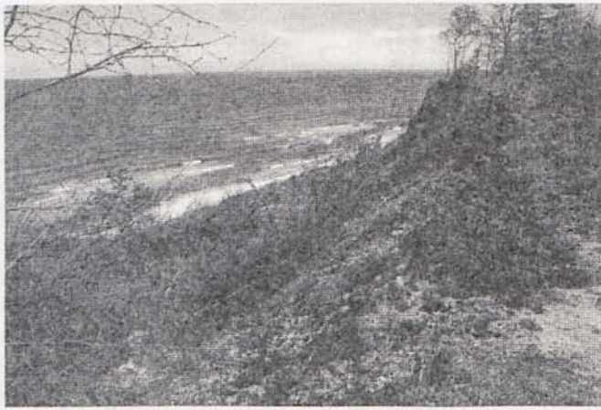
Rys. 3. Brzeg klifowy w Jastrzębiej Górze. Na zboczu klifowym rozwinięte jest duże osuwisko. (Fot. T. Chmielowiec)
