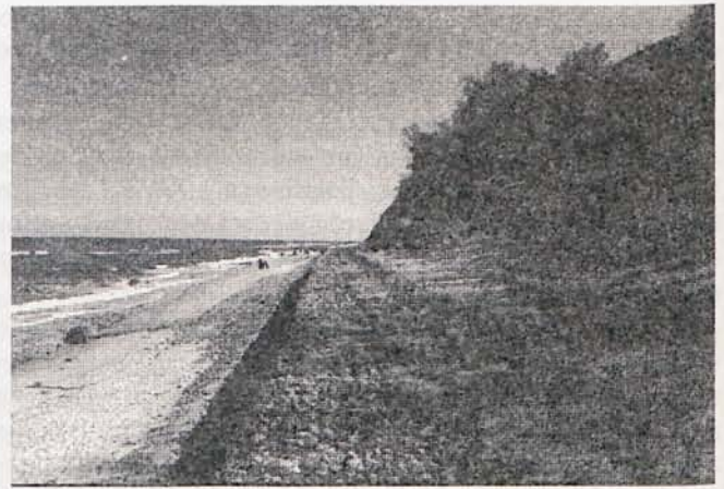
Rys. 4. Brzeg klifowy w Jastrzębiej Górze. U podnóża opaska brzegowa zbudowana z "gabionów". (Fot. T. Chmielowiec)
