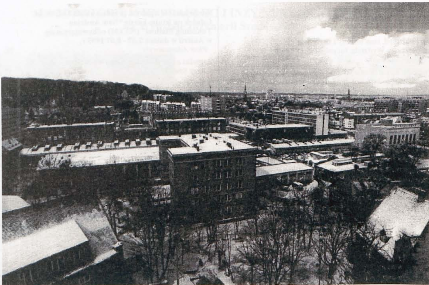
Budynek Wydziału Inżynierii Środowiska. (Fot. A. Pacek)
