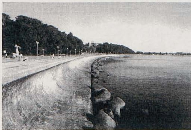
Rys. 2. Opaska brzegowa typu ciężkiego: tak zwany "Bulwar Szwedzki" w Gdyni. (Fot. T. Chmielowiec)
