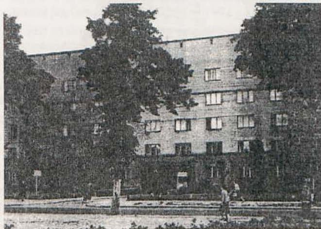
Rys. 5. Zespół mieszkaniowy w Gdyni, ul. Morska 108/112 (tzw. "Dom Magistracki"), zbudowany w latach 1928-29, stan z lat trzydziestych. Ta prosta, lecz starannie zakomponowana elewacja została w latach dziewięćdziesiątych pomalowana w jaskrawe wzory geometryczne, zupełnie nie związane ani ze strukturą budynku, ani z tradycją stosowania koloru w architekturze międzywojennej.
