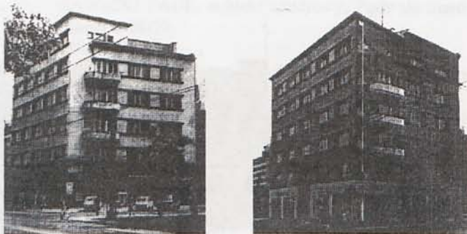
Rys. 3. Kamienica Orłowskich, Gdynia, ul. 10 Lutego 5: a) stan przed rozbudową, b) stan po prowadzonej w początkach lat dziewięćdziesiątych rozbudowie i modernizacji. Zabudowany został wówczas uskok ostatniej kondygnacji od strony ul. Abrahama i zmieniony wystrój kondygnacji parteru.
