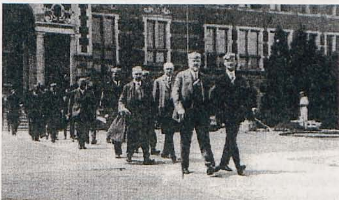
Zjazd w 1938 roku. Przed Gmachem Głównym Politechniki. (Zdjęcie ze zbioru W. Heppnera)
