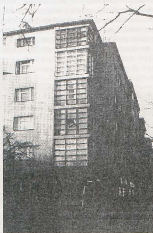
Rys. 7. Kamienica W. Tuchółki, Gdynia, ul. Armii Krajowej 9, zbudowana w 1936 r.; stan sprzed przebudowy wystroju parteru. Ładnie ukształtowane okno wystawowe narożnika zostało w 1993 r. przebudowane.
