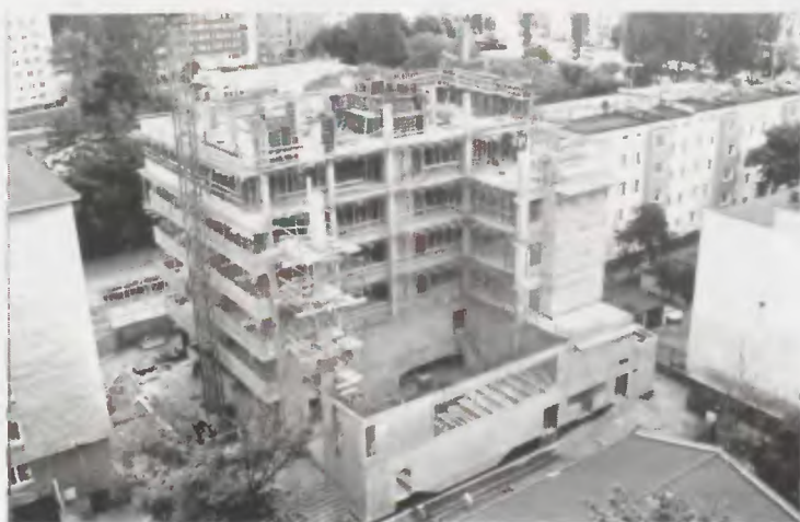
Kolejne etapy budowy budynku Instytutu Oceanografii (20.05.2005; 29.05.2005; 12. 06.2005)
