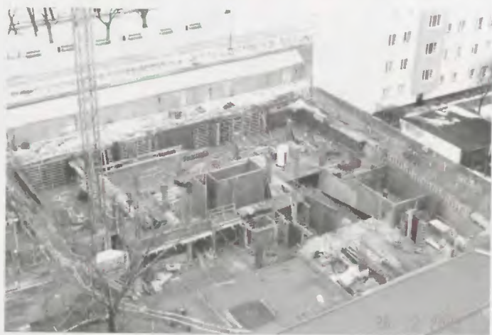
Początkowe etapy budowy budynku Instytutu Oceanografii (23.10.2004; 25.01.2005; 26.02.2005)
