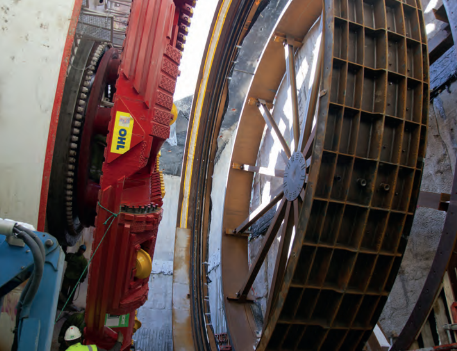
Fot. 1. Widok na ścianę okularową wraz z fragmentem tarczy TBM Fot. z archiwum GIK
