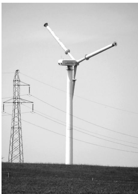
Rys. 5.3. Turbina wiatrowa z rotorami Magnusa Źródło: opracowanie własne
