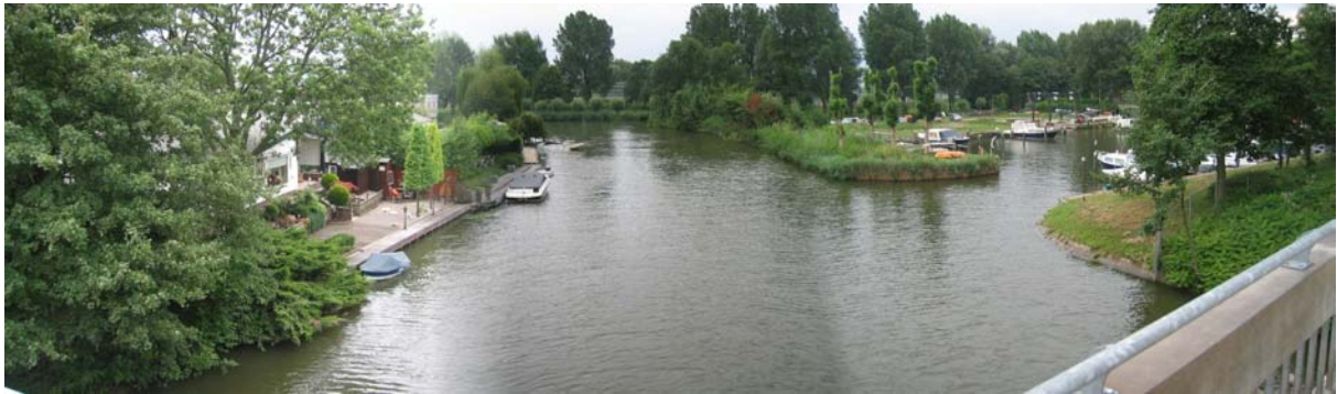
Fot. 5.57. Nijmegen, zabudowa o wysokim standardzie, z własnym nabrzeżem. Woda jako bariera dostępu umożliwia utrzymanie poziomu bezpieczeństwa i gwarancję prywatności bez potrzeby wydzielenia posesji płotem, co wizualnie uatrakcyjnia taką lokalizację. Przestrzeń kanału ujęta w ramach wnętrza urbanistycznego o charakterze półprywatnym.
