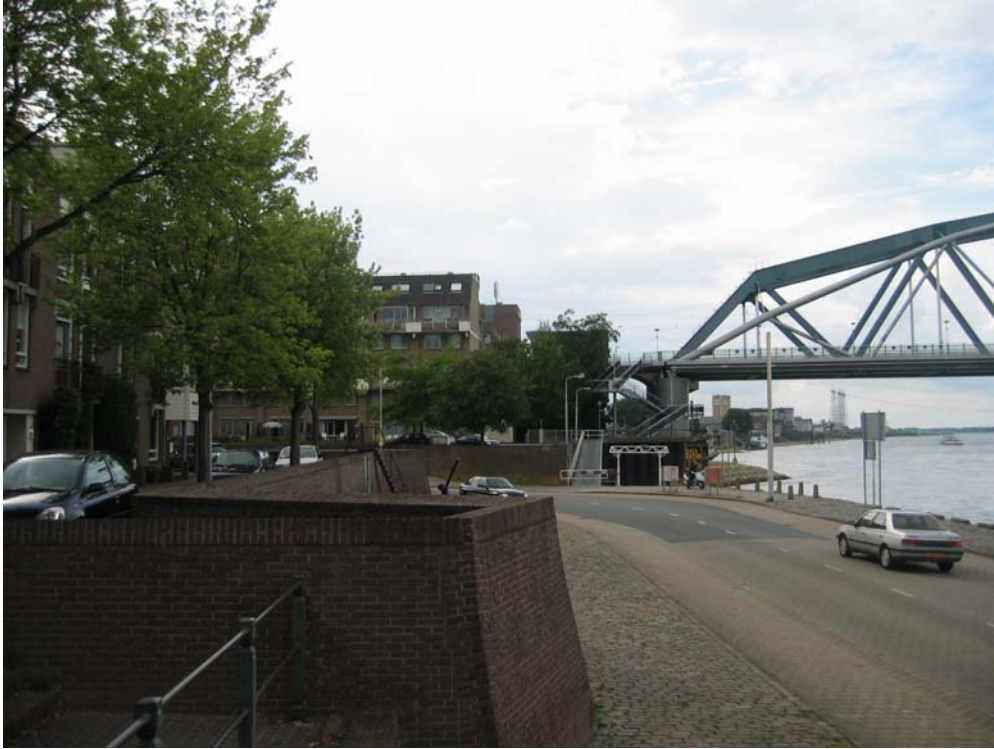
Fot. 5.42. Wyższy taras to zabezpieczenie przeciwpowodziowe, jak również wydzielenie wizualne obszaru półprywatnego przynależnego do zabudowy mieszkaniowej od przestrzeni ogólnodostępnej.
