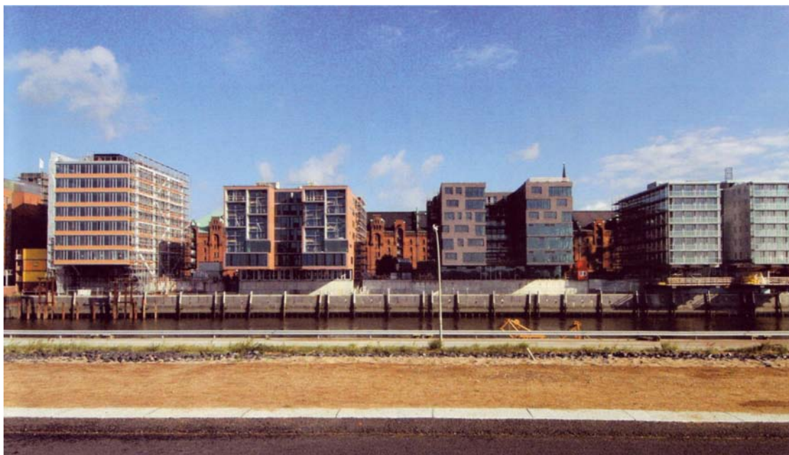
Fot. 5.85. Zabudowa HafenCity w trakcie realizacji. Rytm budynków generujący front wodny.
