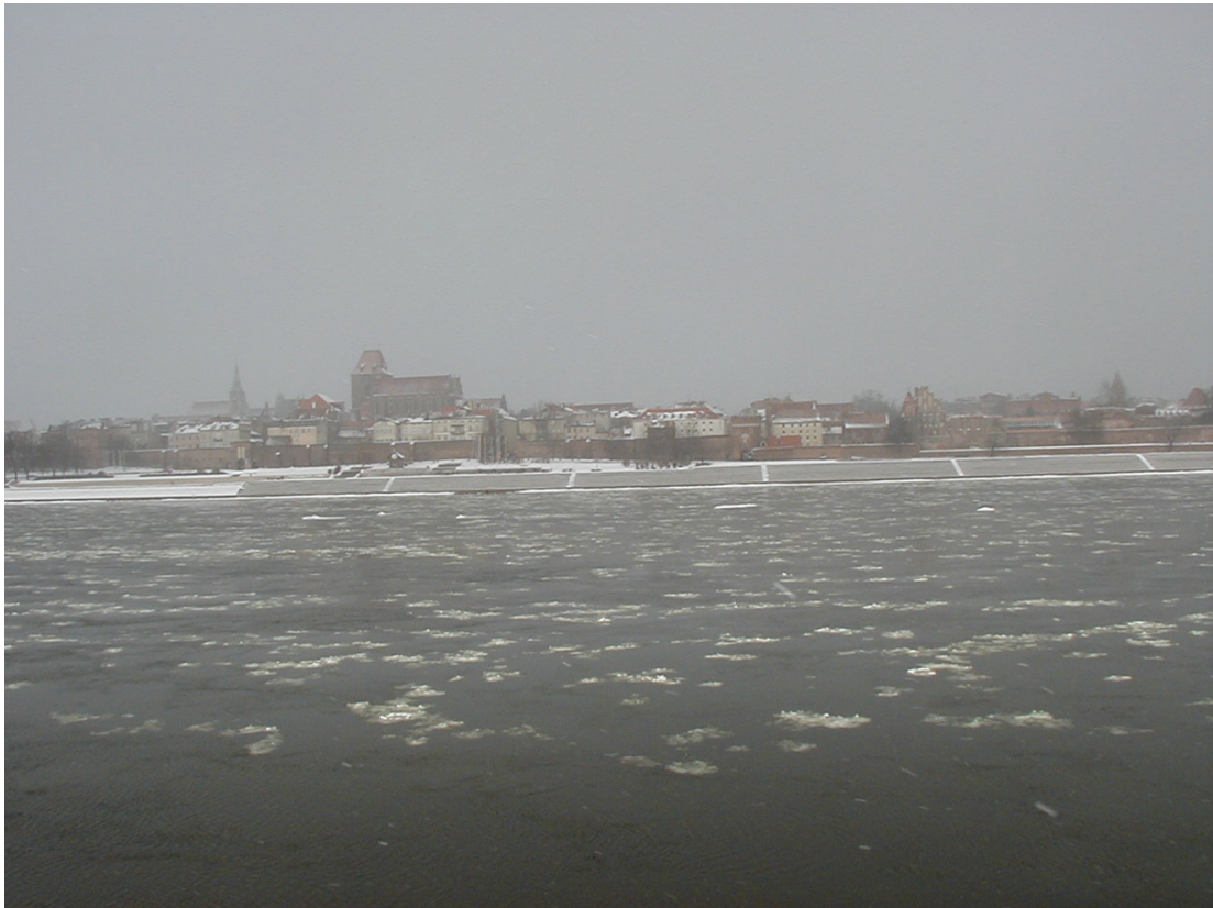
Fot. 5.119. Front wodny prawobrzeżnego Torunia. Na pierwszym planie Bulwar filadelfijski, w tle historyczne śródmieście o wysokich walorach kulturowych. Zdjęcie z prowizorycznego punktu widokowego stworzonego na Kępie Bazarowej, do którego brak jednak poprawnie zaaranżowanego dojścia od strony miasta.
