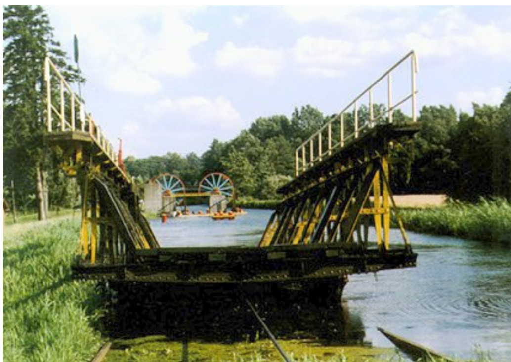
Fot. 4.5. System pochylni na kanale Ostródzko – Elbląskim
