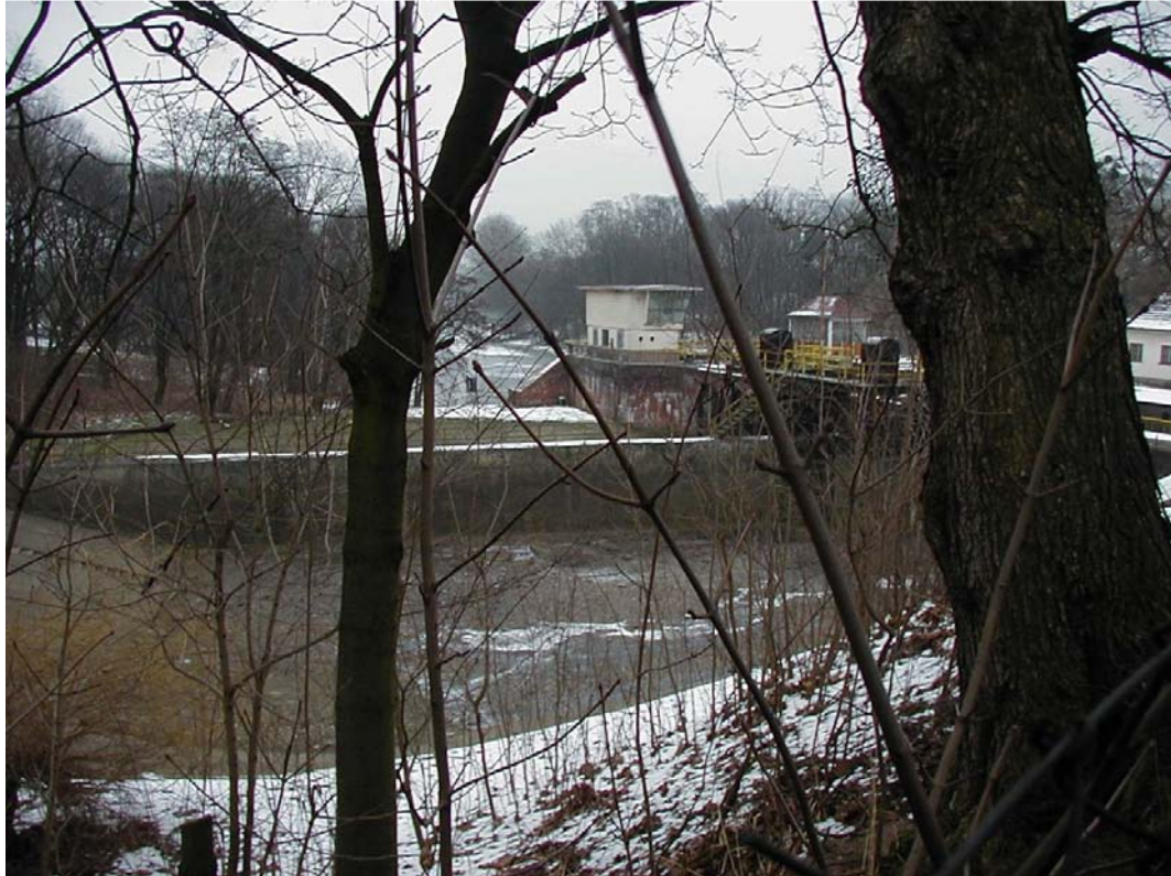
Fot. 5.115. Śluza Młynarska na Kanale bydgoskim; przykład architektury II połowy XX wieku.
