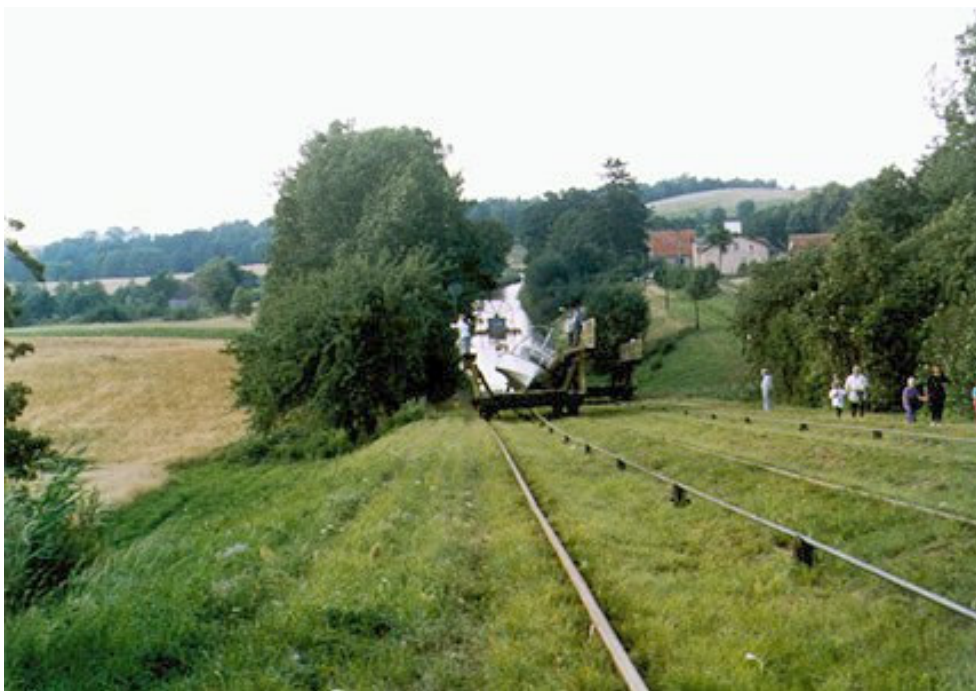
Fot. 4.4. System pochylni na kanale Ostródzko – Elbląskim
