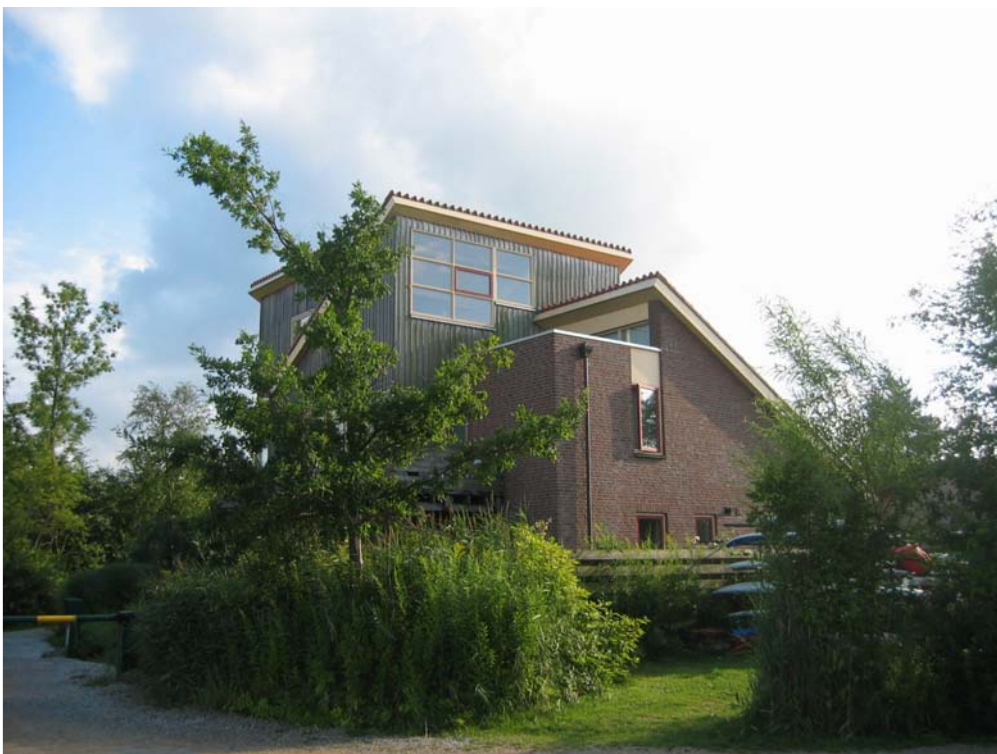
Fot. 5.58. Leek, brak możliwości wglądu na posesję od strony publicznej umożliwia rozwiązanie wnętrza urbanistycznego o charakterze prywatnym, otwartego na wodę. Bryła budynku utrzymana w kontekście zabudowy podmiejskiej ze świadomie przyjętymi rozwiązaniami umożliwiającymi szeroki wgląd na tereny frontu rzecznego.
