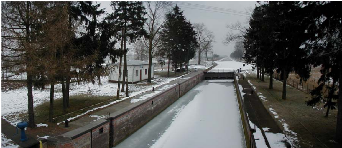
Fot. 5.106. Występ - Kanał bydgoski; śluza i stopień piętrzący Józefinka. Element kubaturowy wymuszający postój na drodze wodnej. Brak zaplecza poza budynkiem socjalnym obsługi śluzy. zorganizowanie podstawowej infrastruktury w oparciu o istniejące media i zaplecze gospodarcze w postaci miejscowości umożliwi podniesienie standardu miejsca o usługi związane z turystyką przy okazji śluzowania.
