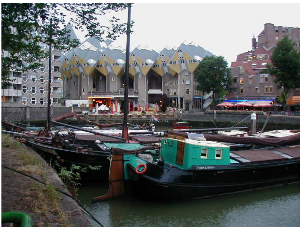
Fot. 5.71., fot.5.72. Architektura na wysokim poziomie i wszechobecne funkcje dostępne dla przechodniów to gwarancja niebanalnego wnętrza publicznego. Współczesna forma w dialogu z historyczną funkcją miasta portowego
