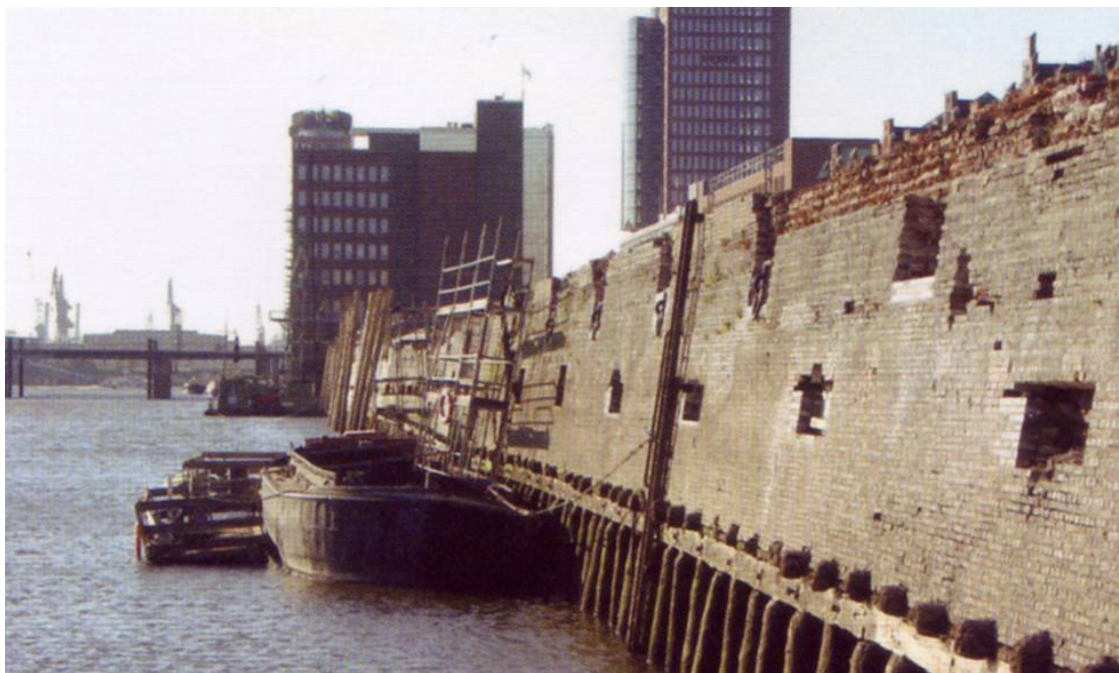
Fot. 5.86. Nabrzeża basenów portowych przed transformacją.
