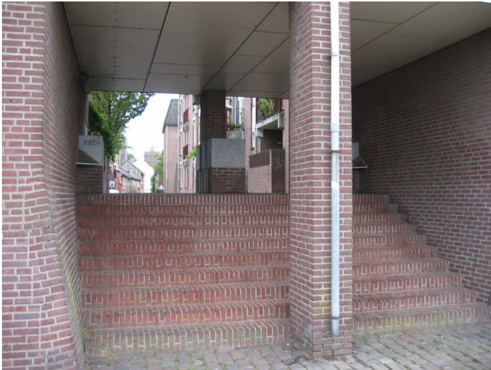
Fot. 5.44. Odpowiednie zaprojektowanie poziomów terenu umożliwia zapewnienie ochrony przeciwpowodziowej przy dyskretnej, nienachalnej formie i oszczędnych środkach wyrazu.
