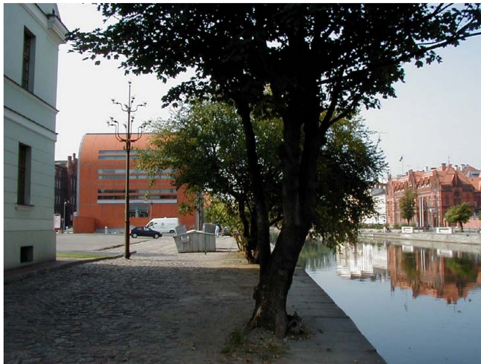
Fot. 5.113, Współczesna zabudowa usługowa śródmieścia nawiązująca do historycznej architektury nabrzeży portowych Brdy
