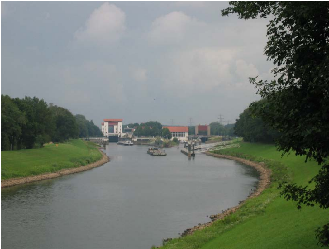
fot.5.6.Horstel, śluza na Mitellandkanal, powstające w okolicy campingi nastawione są na turystykę tematyczną związaną z żeglugą śródlądową. Architektura obiektów hydrotechnicznych jest dziedziną samą w sobie ze względu na ścisły związek z technologią, a z drugiej strony z otoczeniem.
