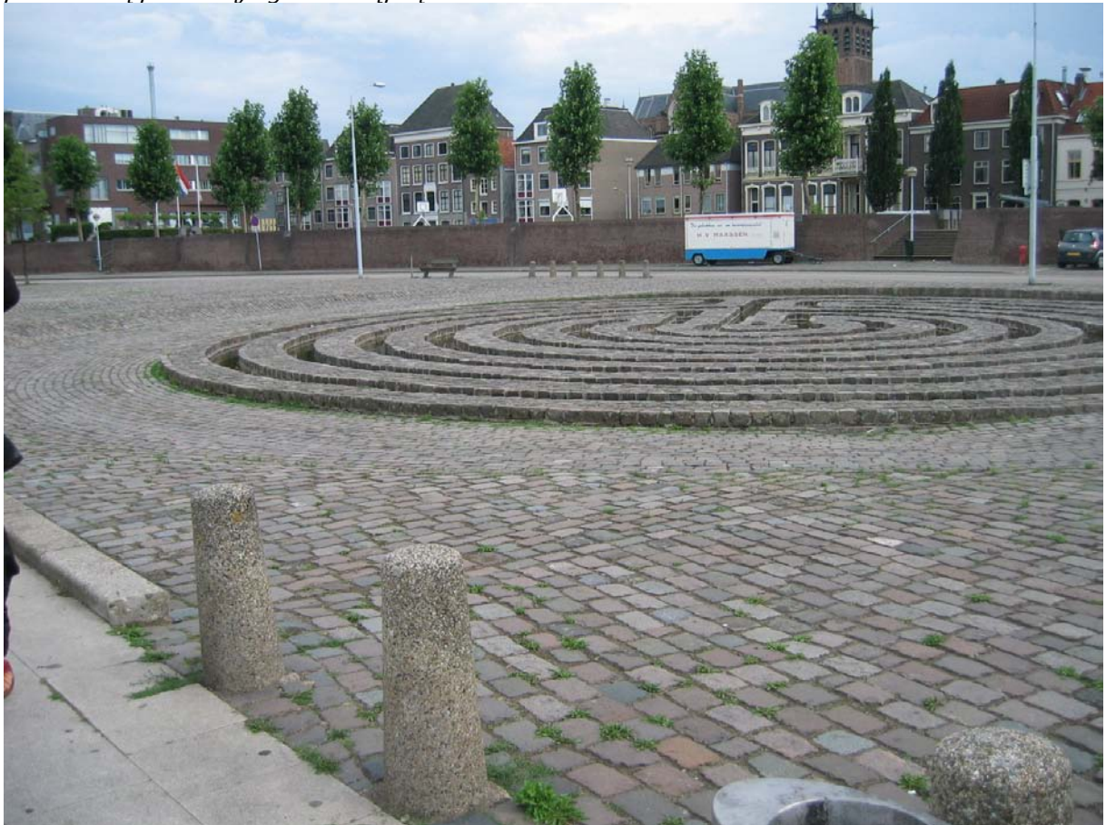
Fot. 5.41. Zaaranżowanie przestrzeni publicznej przy pomocy materiałów odpornych na działanie wody pozwala na szybkie usunięcie skutków powodzi, a tym samym sprawny powrót do życia śródmieścia; widoczna w tle różnica poziomów pełni rolę wału przeciwpowodziowego, nie przesłaniając przy tym widoku na rzekę i unikając wrażenia „mieszkania w okopie”
