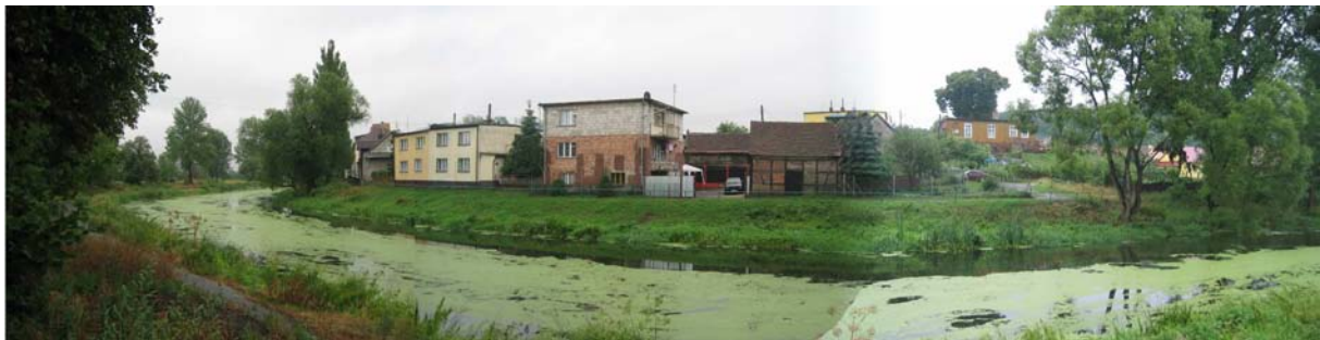
Fot. 5.98. Zdegradowana i chaotyczna zabudowa frontu wodnego w Ujściu
