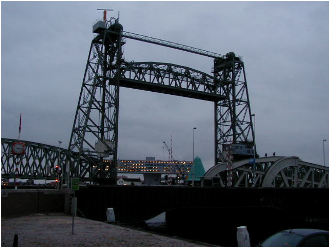
Fot. 5.67 Rotterdam, Przeplatające się elementy architektoniczne i inżynieryjne tworzą specyficzną atmosferę miejsca
