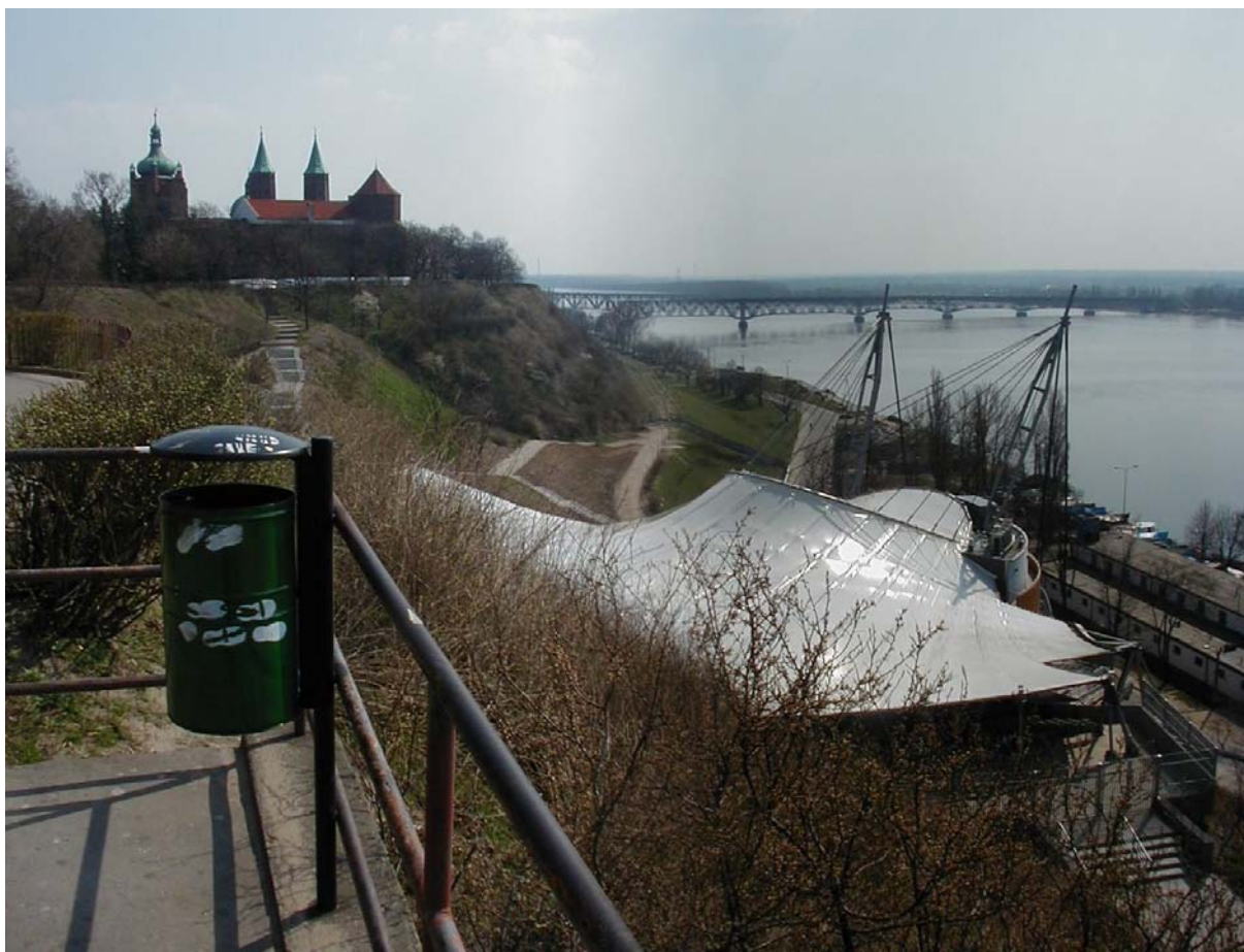
Fot. 5.140. Płock. Współczesna szczerza forma amfiteatru w kontekście historycznej tkanki miasta. Rytm ceglanych wież i stalowych masztów amfiteatru to dialog historii ze współczesnością.
