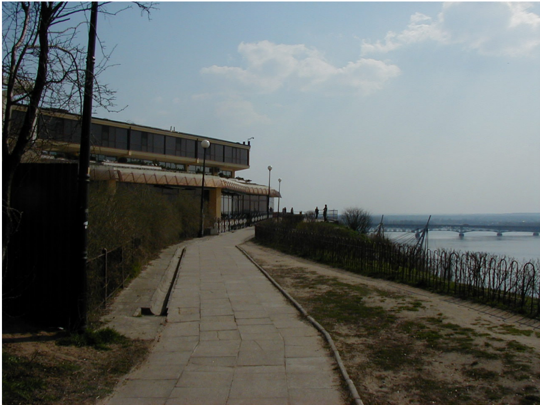
Fot. 5.143. Płock. Współczesna zabudowa hotelu wykorzystująca te same walory miejsca; sala konsumpcyjna i pokoje skierowane na stronę południową z widokiem na panoramę frontu miasta.
