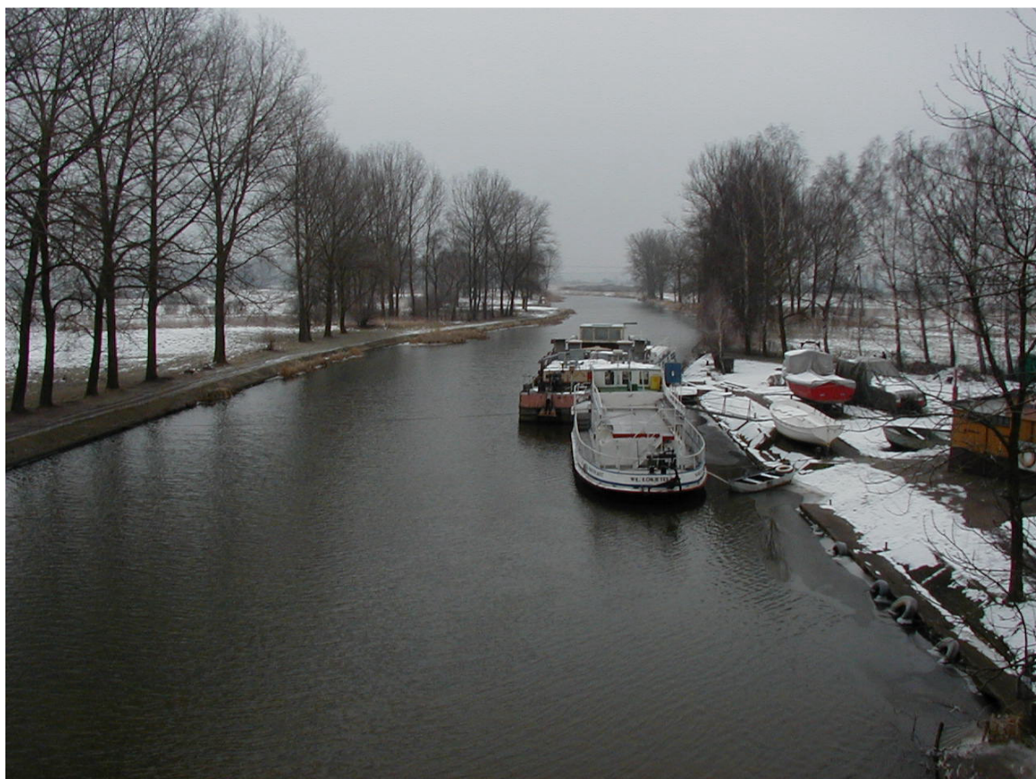
Fot. 5.102, Kanał Notecki w Nakle nad Notecią. Istniejąca przystań żeglugowa. Po lewej stronie zlokalizowana jest tkanka miejska
