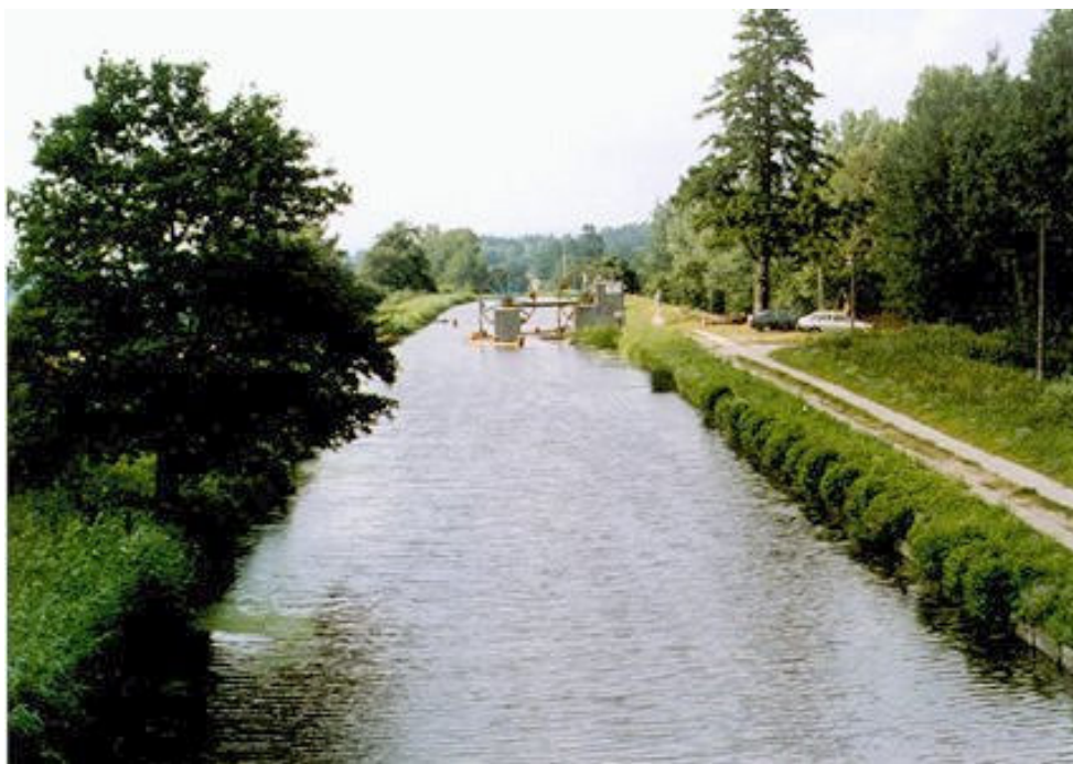
Fot. 4.3. System pochylni na kanale Ostródzko – Elbląskim
