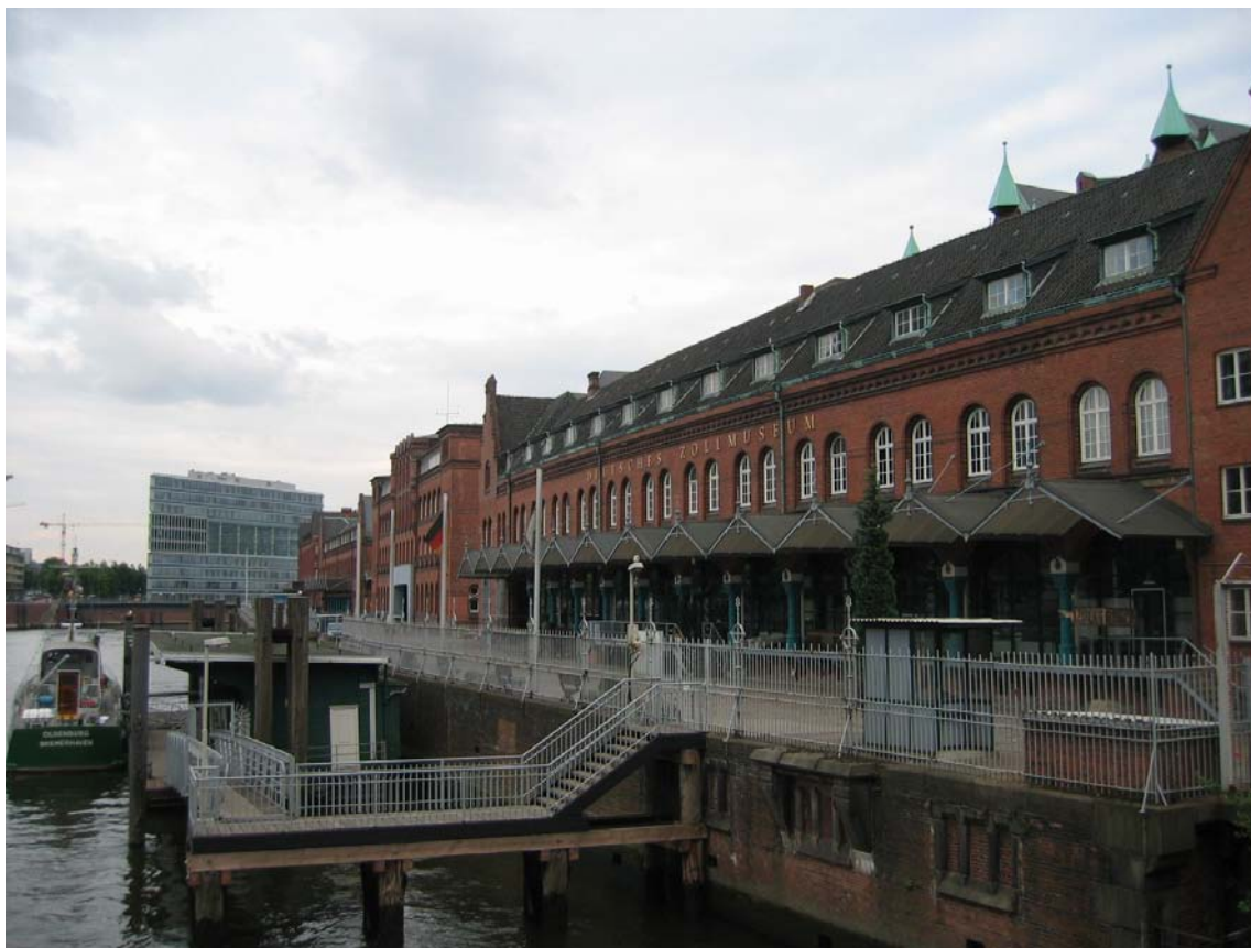
Fot.3.12. Hamburg, zabudowa nabrzeży związana z obsługą komunikacji wodnej.
