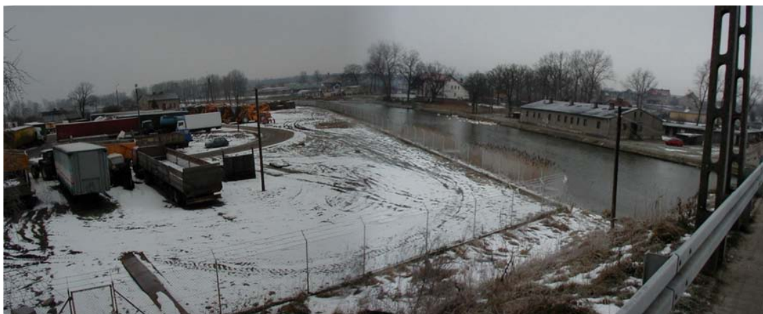
Fot. 5.101, Zdegradowane przestrzenie nad kanałem Noteckim o przypadkowych funkcjach nie związanych ze specyfiką miejsca.
