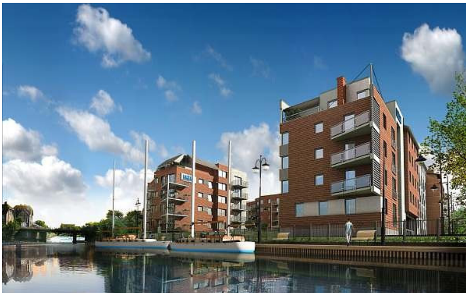
Fot.3.10, 3.11. Założenie „Nowa Lastadia” nad Motławą, Gdańsk. Przykład rewaloryzacji zdegradowanej przestrzeni nadrzecznej i rehabilitacji obszarów frontów wodnych miasta.
