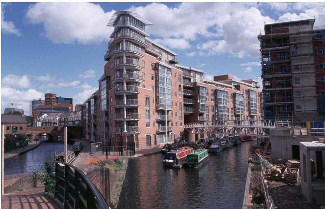
Fot. 6.7, Birmingham, zabudowa mieszkaniowa i usługowo-handlowa w kontekście dróg wodnych o znaczeniu transportowym i turystycznym
