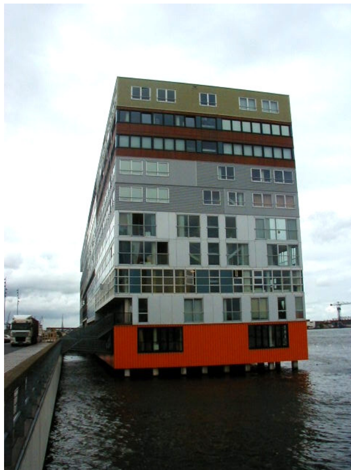
Fot.5.33, fot.5.34. Budynek mieszkalny „przycumowany” przy nabrzeżu. Forma zapożyczona ze specyfiki przestrzeni portowej; moduł kontenera tworzy rytm elewacji i podziałów wewnętrznych budynku.
