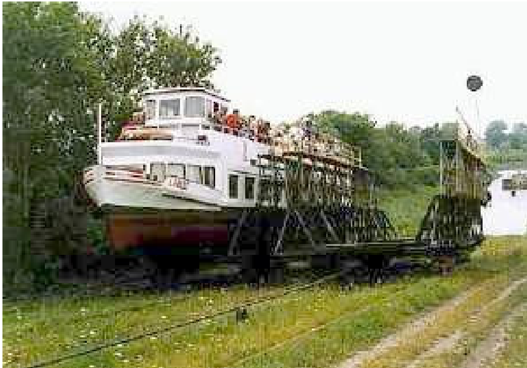
Fot. 4.6. System pochylni na kanale Ostródzko – Elbląskim
