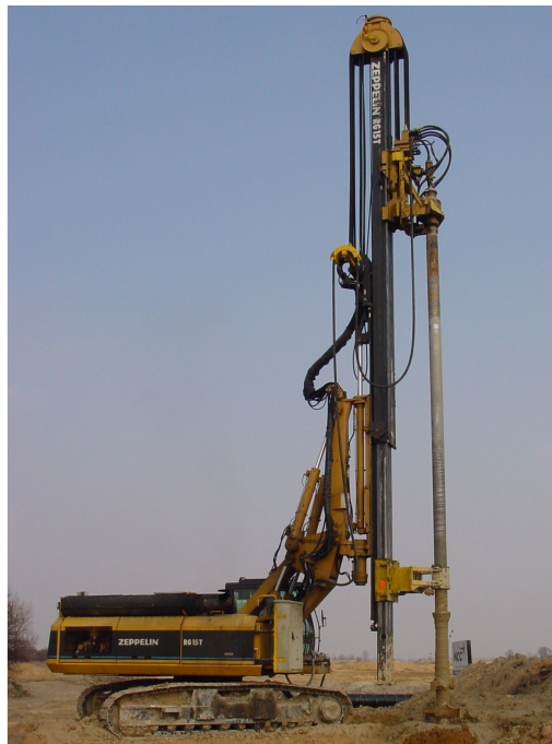
Rys. 2.2 Wiertnica z pojedynczym mieszadłem.
