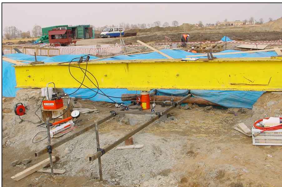
Rys. 5.25 Próbne obciążenie kolumny badawczej DSM.
