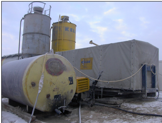
Rys. 2.1 Stacja przygotowania i podawania zaczynu.
