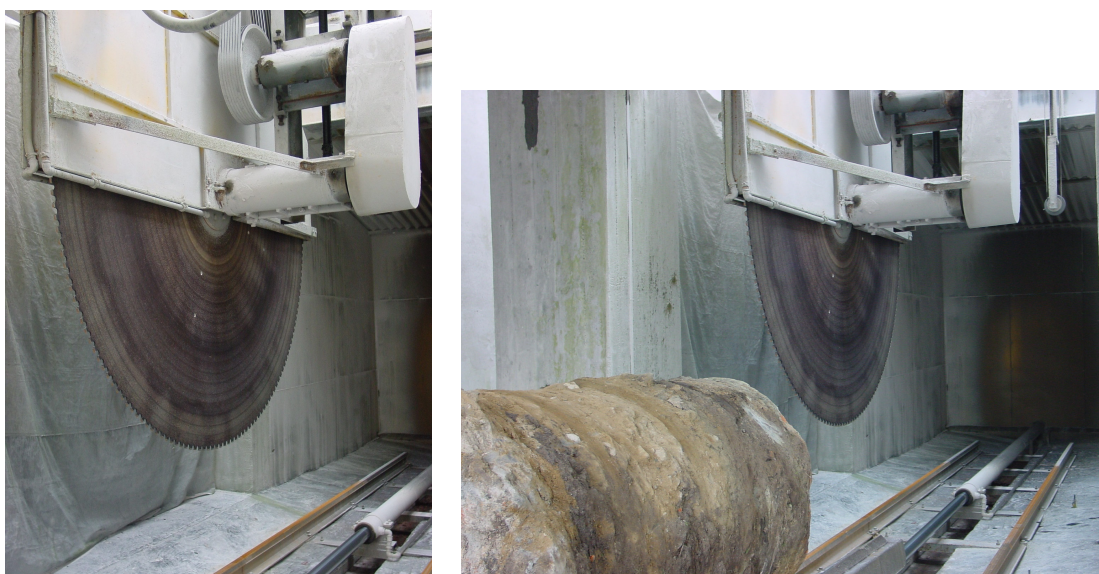
Rys. 5.13 Piła tarczowa i kolumna przygotowana do przecięcia.
