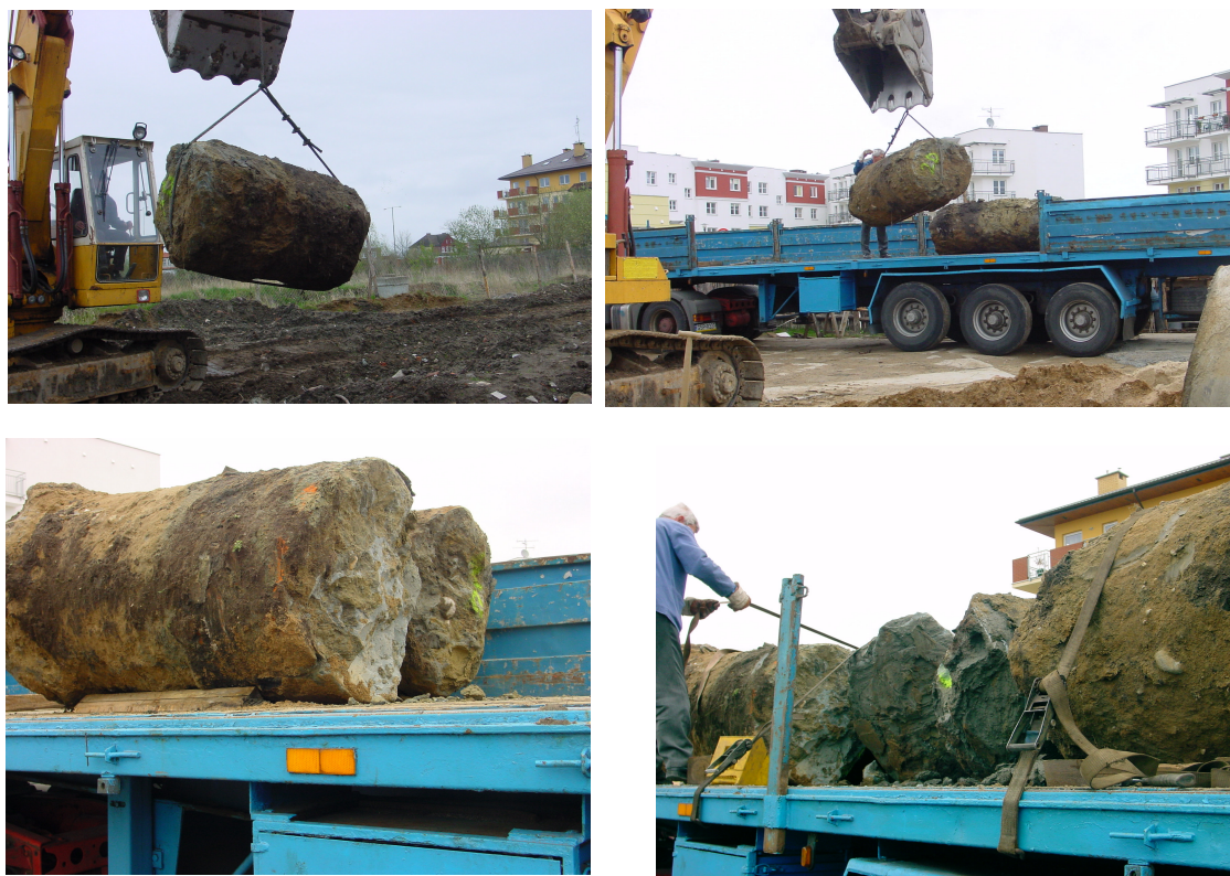
Rys. 5.12 Transport wydobytych kolumn badawczych z placu budowy do zakładu kamieniarskiego koło Gdyni.
