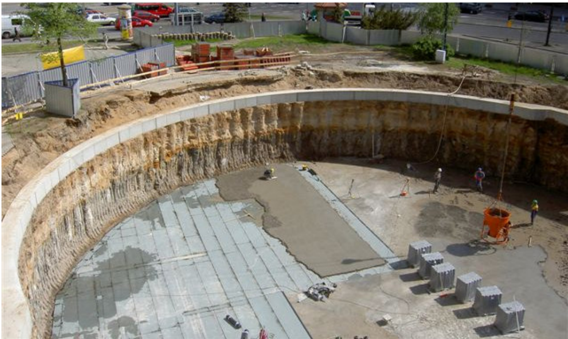
Rys. 2.13 Palisada z kolumn DSM; Sala Koncertowa Akademii Muzycznej w Poznaniu.
