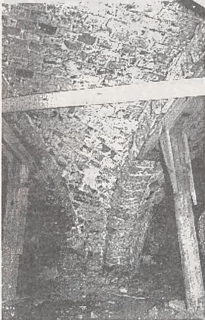
Jeden z filarów piwnicznych budynku "D" Przedzamcza. Stan z 1990 r.
