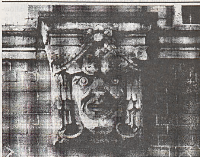
Detal architektoniczny z Gmachu Głównego
