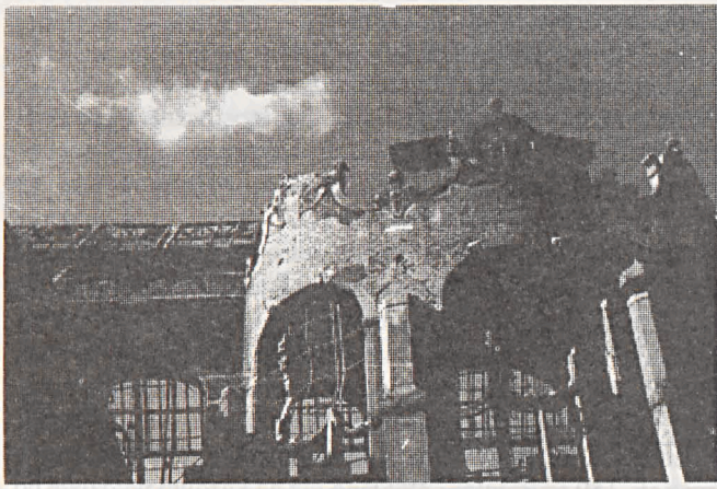
Zniszczony Gmach Główny. Zdjęcie ze zbiorów Pracowni Historii Politechniki Gdańskiej. Foto: M. Dobrzański
