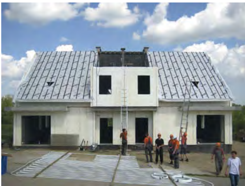
Dr hab. inż. Marek Krzaczek oraz zdjęcie z budowy budynku testowego w Warznie (woj. pomorskie)
