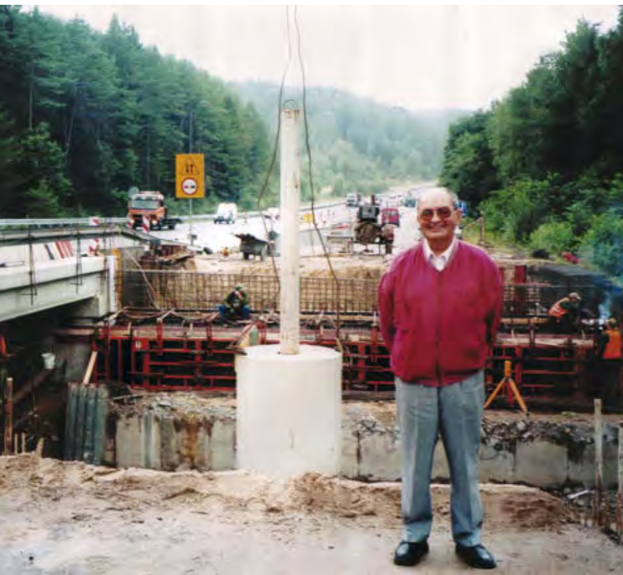
Na budowie, 2003 r. Fot. ze zbiorów prywatnych
