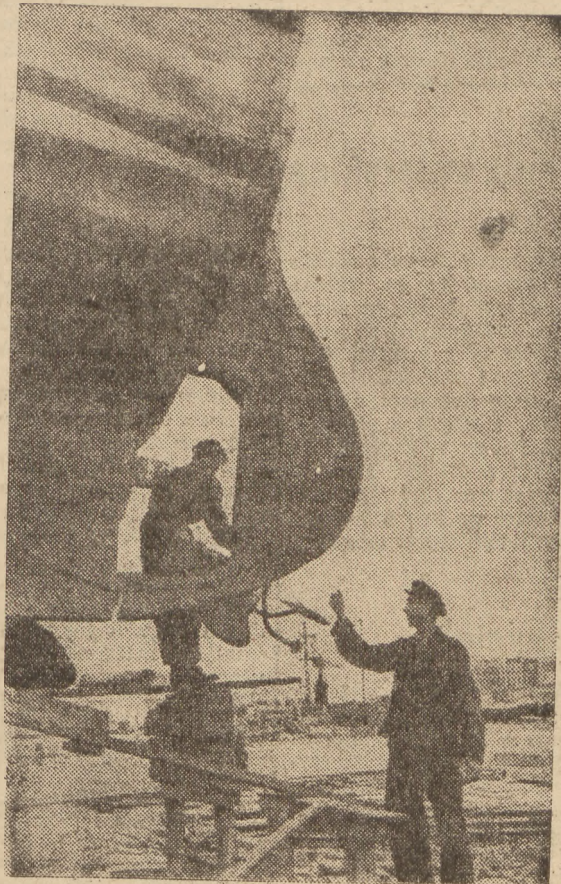
Stocznia rybacka w Gdyni. Remont łodzi
