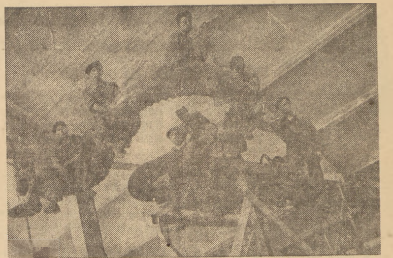
To nie cyrk, ani występy zespołu świetlicowego... Trzeba nie lada zręczności, aby wykonać trudną i odpowiedzialną robotę, jaką jest smontowanie głównego rurociągu parowego
