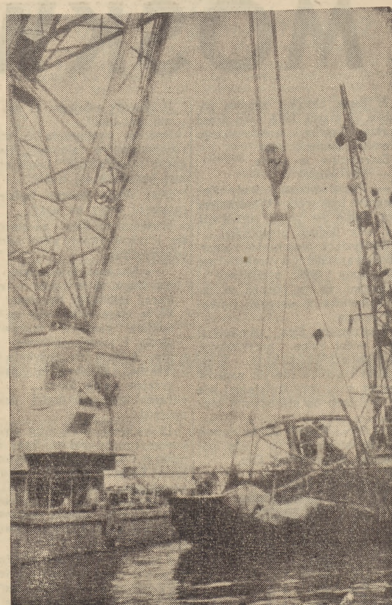
100-tonowy dźwig przy pracy w porcie szczecińskim
