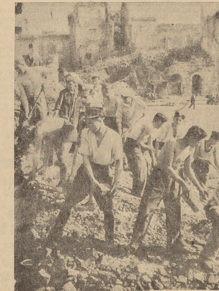
Robotnicy W.P. dnia 17. bm. pracowali przy odbudowie Warszawy
