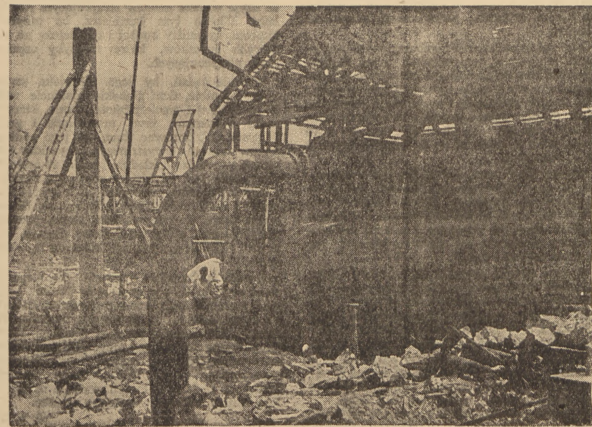
Tak wyglądała kotłownia w bazie CPN, w Nowym Porcie w roku 1944
