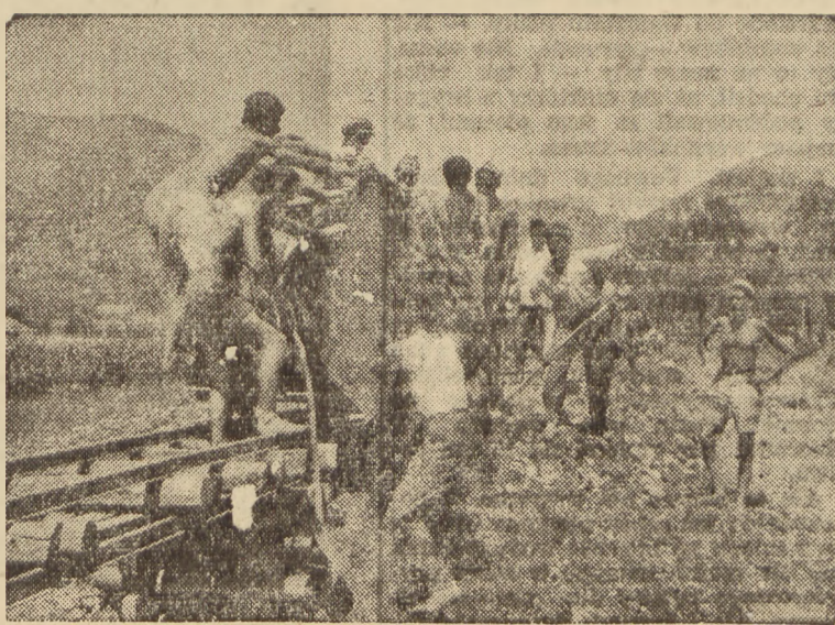
Budowa linii Szamac — Sarajewo
