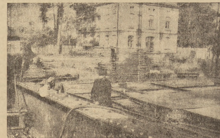
WYKONANIE DZIAŁA MOSTOWEGO.
